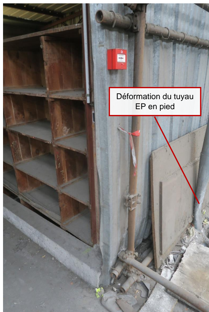
Vues tuyaux de descente EP bâtiment 4
