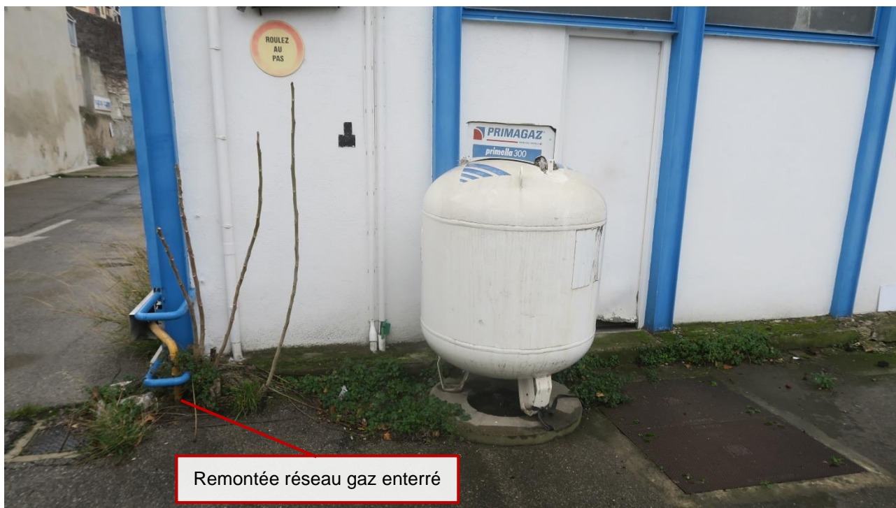
Vues équipements gaz façade Nord bâtiment 2
