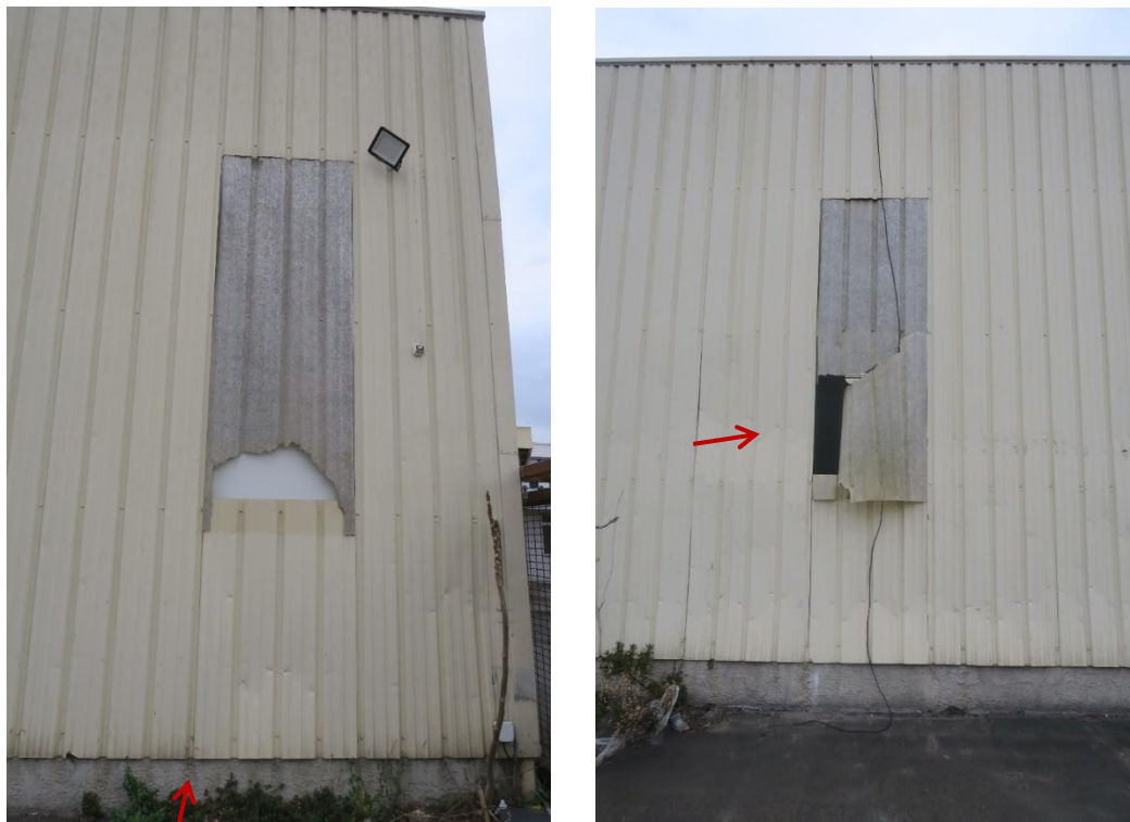
Vues éclats tôles polycarbonates fermeture des baies
