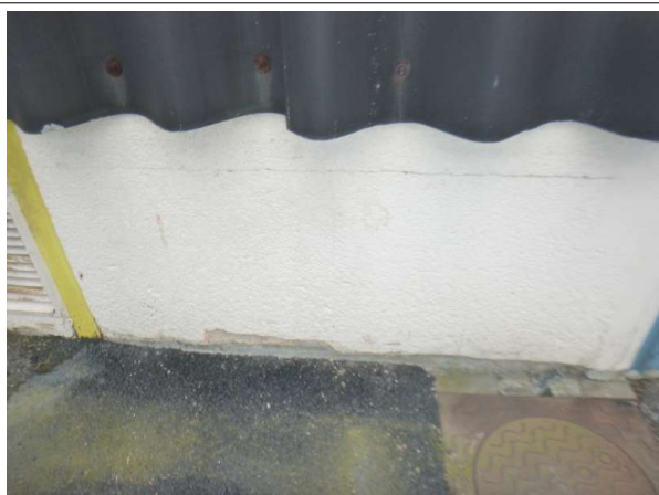
Prélèvement - P003 : Extérieur / Façades - Enduit projeté- (Absence d'amiante)
