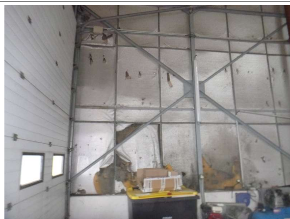
Prélèvement - P005 : Enveloppe du bâtiment - Isolant sous bardage- (Absence d'amiante)
