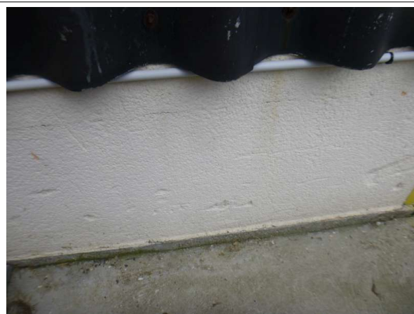
Prélèvement - P004 : Extérieur / Façades - Enduit projeté- (Absence d'amiante)
