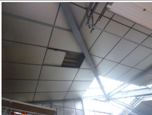
Prélèvement - P006 : Enveloppe du bâtiment - Faux plafond- (Absence d'amiante)
