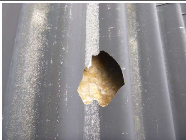
Prélèvement - P001 : Extérieur / Façades - Bac en fibre-ciment- (Présence d'amiante)
