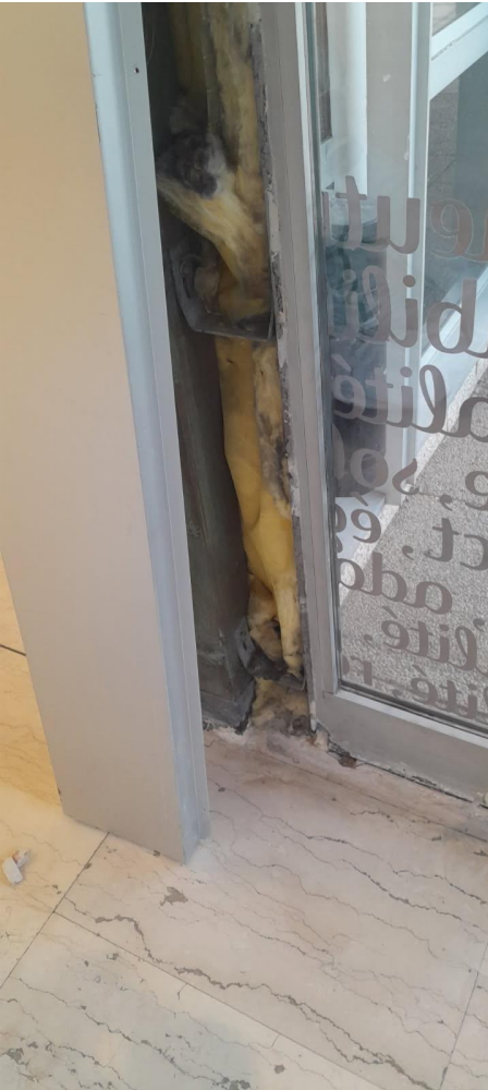
PHOTO DU CAPOTAGE DEPOSE ET DE L'ACTUEL SYSTEME DE FIXATION DU CHÂSSIS
