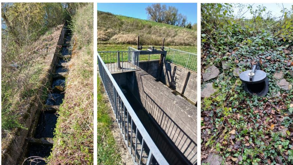
Figure 3 Ouvrages de génie civil. A gauche, passe à poissons. Au centre, vannage de la passe. A droite, clapet anti-retour des drains de la recharge drainante
