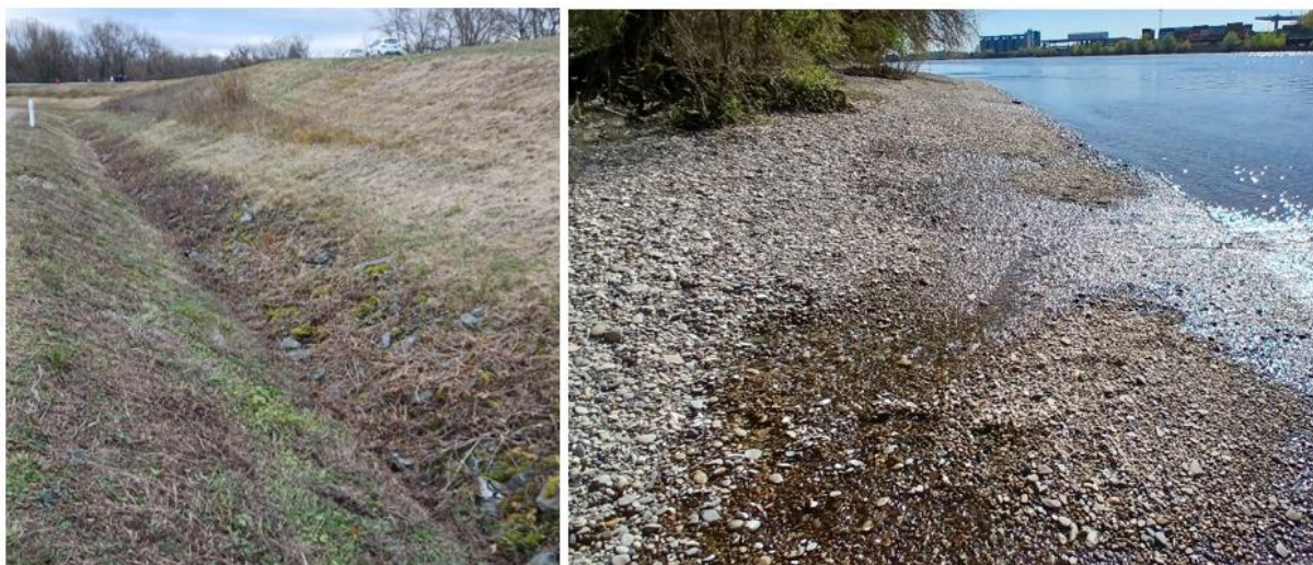
Figure 2 Abords immédiats de l'ouvrage. A gauche, fossé drainant dans la partie en « U » de la digue latérale. À droite, plages du Grand Canal d'Alsace
