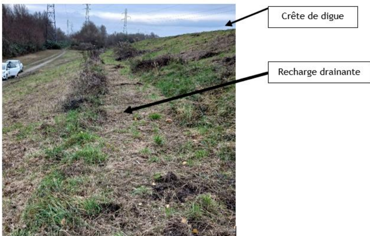
Figure 1 Ouvrage en remblai de la digue latérale rive gauche du BKS, partie aval
