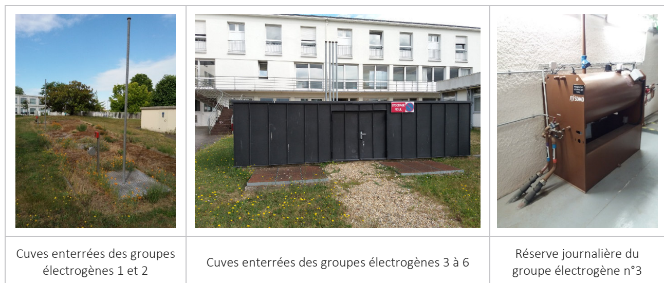
Figure 5 : Illustration des cuves alimentant les groupes électrogènes du site (ICPE n°4734)
