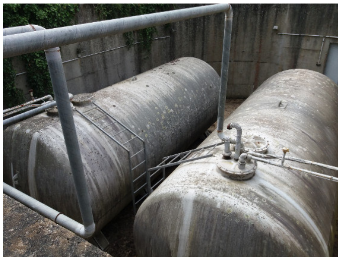
Figure 4 : Illustration des deux cuves alimentant en secours la chaufferie principale du site (ICPE n°4734)
