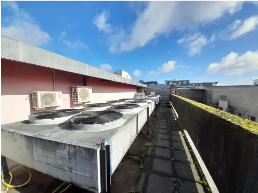
Condenseurs sur toiture
