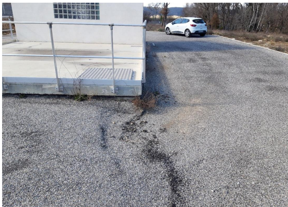
Figure 16 : Autre affaissement de la voirie visible en mars 2019 [R 8]
