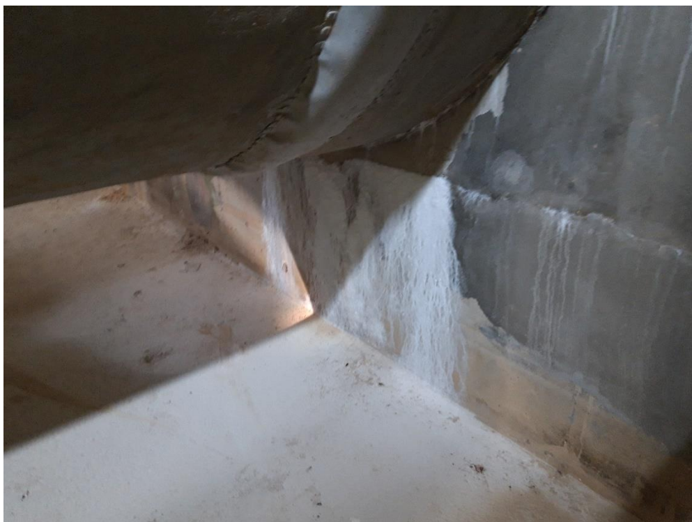
Figure 14 : Infiltration d'eau autour de la canalisation DN1400 - Voile Nord-Ouest [R 8]
