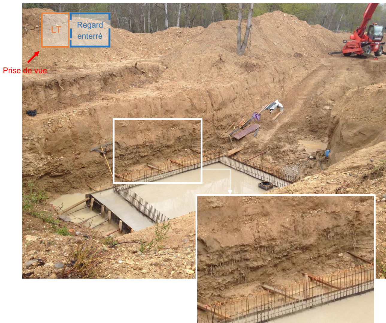
Figure 17 : Photo du radier du regard enterré prise le 08/04/2014 (Source : CEA)
