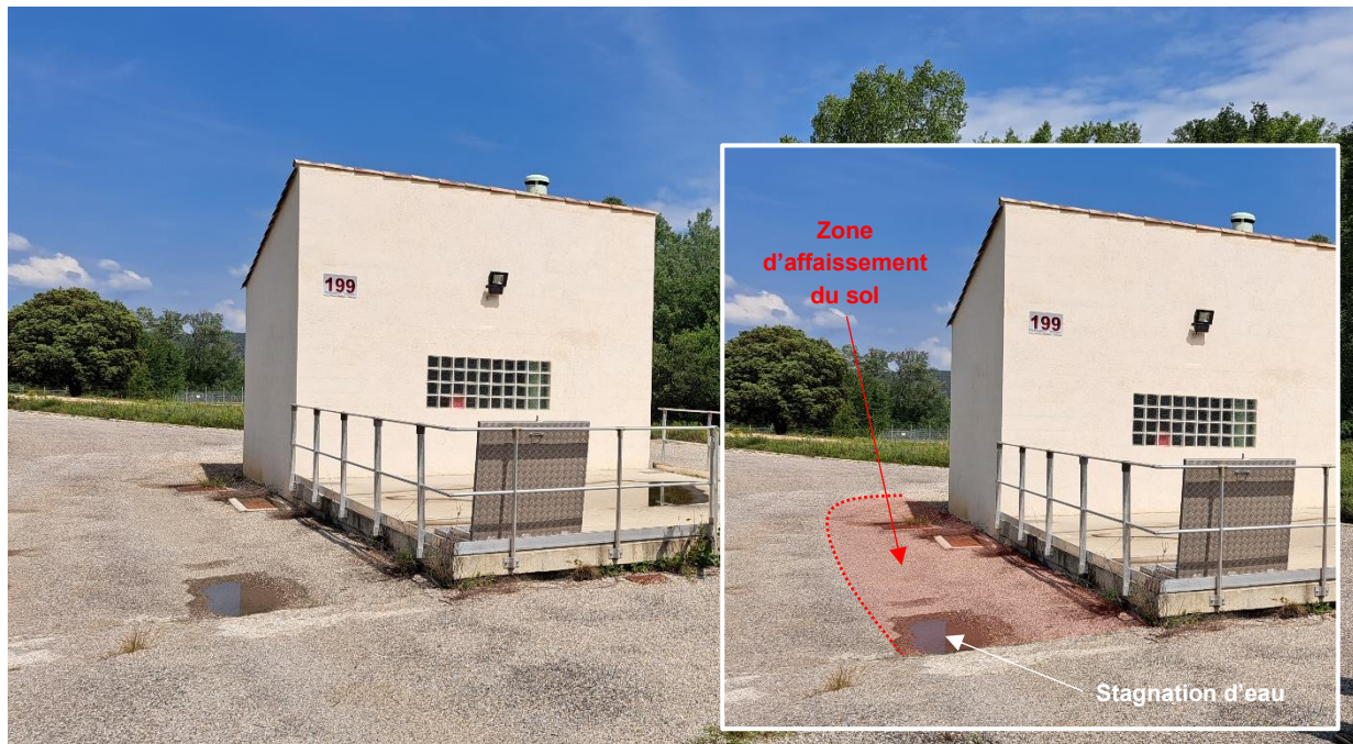
Figure 15 : Affaissement du sol et eau stagnante en périphérie du regard enterré [R 6]
