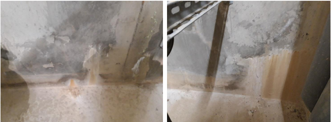
Figure 13 : Infiltration d'eau visibles en pied du voile Nord-Ouest [R 8]
