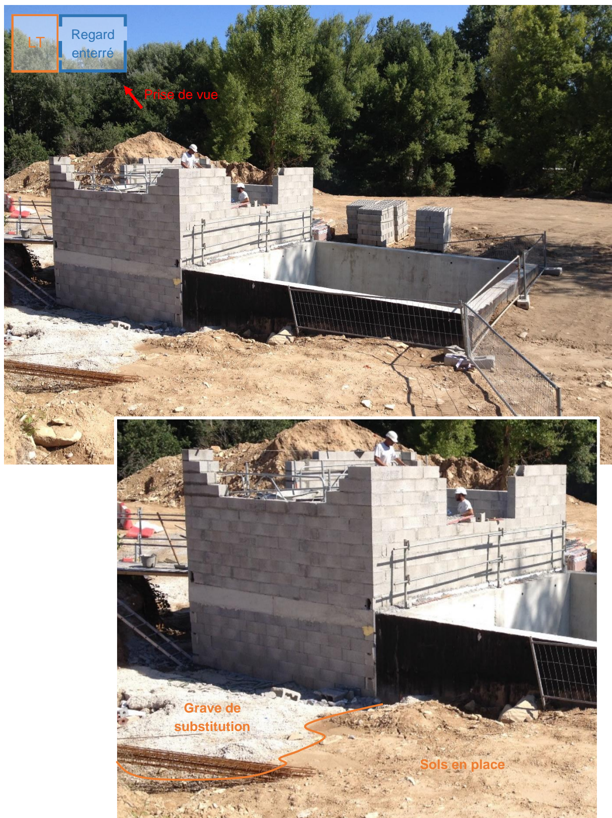
Figure 21 : Substitution des terrains en place sous le local technique (Source : CEA)
