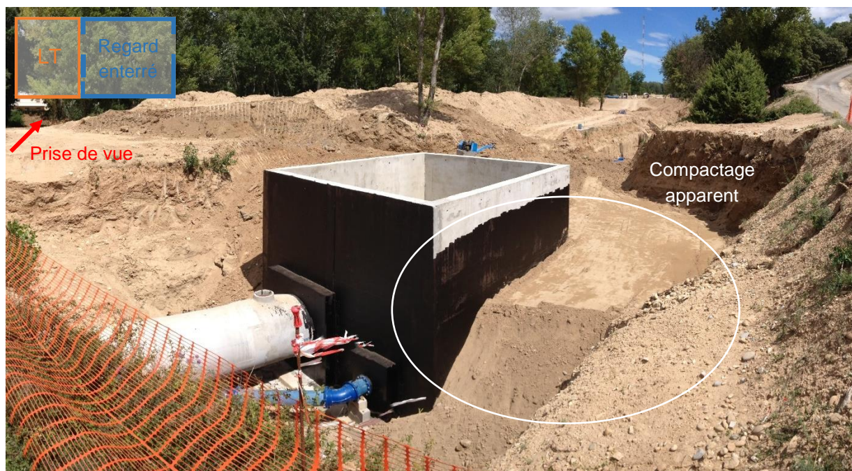
Figure 24 : Compactage apparent des remblais - Photo du 10/07/2014 (Source : CEA)
