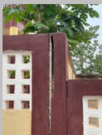
Finition clôture - reprise enduit (valable pour l'ensemble de la clôture)
