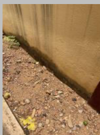
Remontées d'eau à la base de la clôture (valable pour l'ensemble de la clôture)
