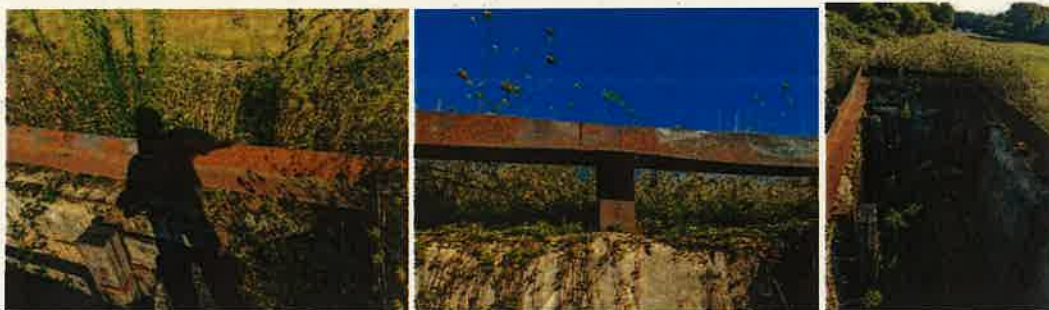
Photo 10: Déformation des profilés métalliques 200x200x20 mm
