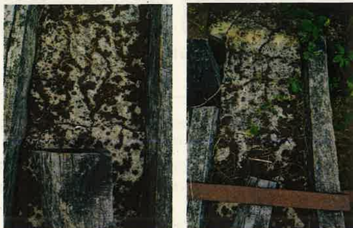
Photo 14: Fracture au niveau de la face supérieure de la poutre
