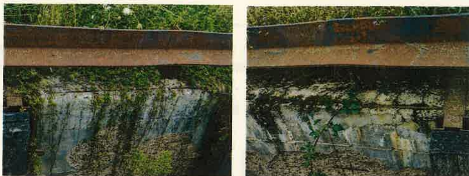
Photo 11: Arrachement du béton sur l'arase des voiles
