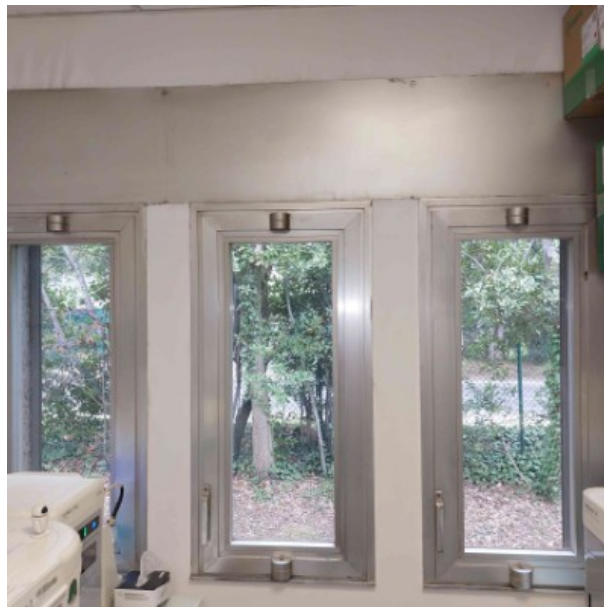
a REZ DE CHAUSSEE / Pièce Z1-6 / Mastic menuiserie alu simple vitrage [ Prélèvement n°26]
