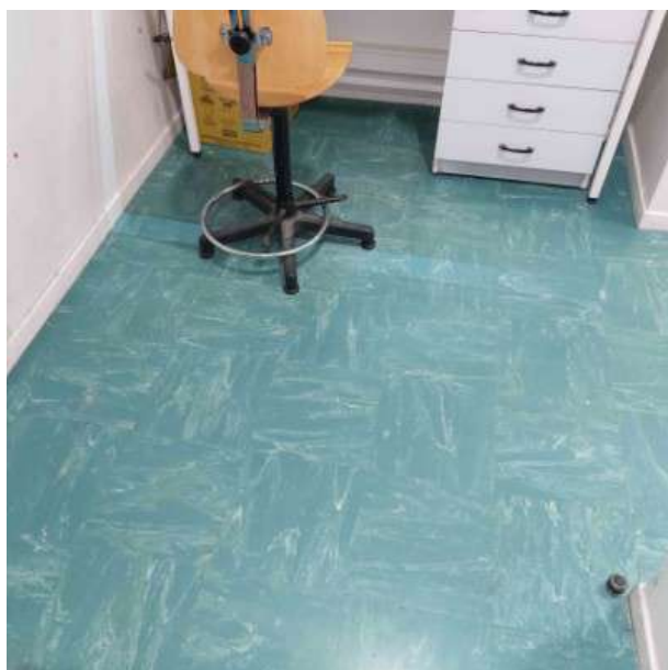
N REZ DE CHAUSSEE / Pièce Z2-18 / Dalle de sol verte + colle + ragréage [ Prélèvement n°15]
