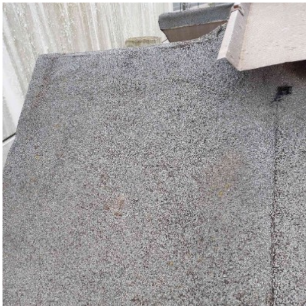
N TOITURE / Etanchéité bitumineuse inférieure [ Prélèvement n°3]
