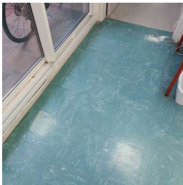
N REZ DE CHAUSSEE / Pièce Z1-7 / Dalle de sol verte + colle + ragréage [ Idem Prélèvement n°15]
