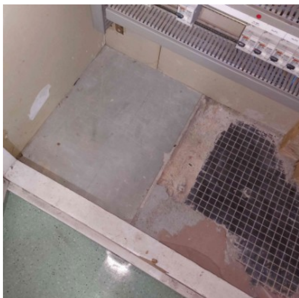
N REZ DE CHAUSSEE / Placard Technique Electrique / Dalle de sol grise + colle + ragréage [ Prélèvement n°13]
