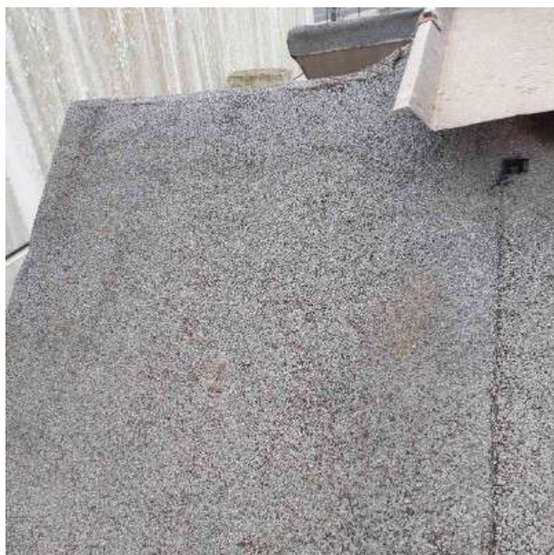
N TOITURE / Etanchéité bitumineuse inférieure [ Prélèvement n°3]
