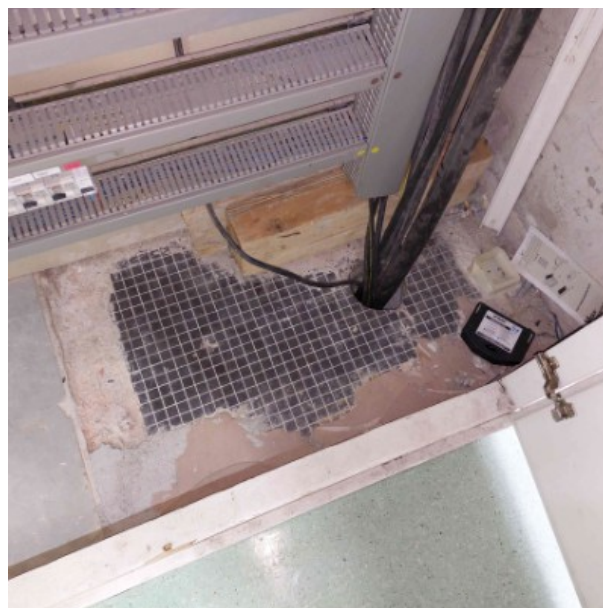
N REZ DE CHAUSSEE / Placard Technique Electrique / Colle de carrelage noire petits carreaux pâte de verre [ Prélèvement n°14]
