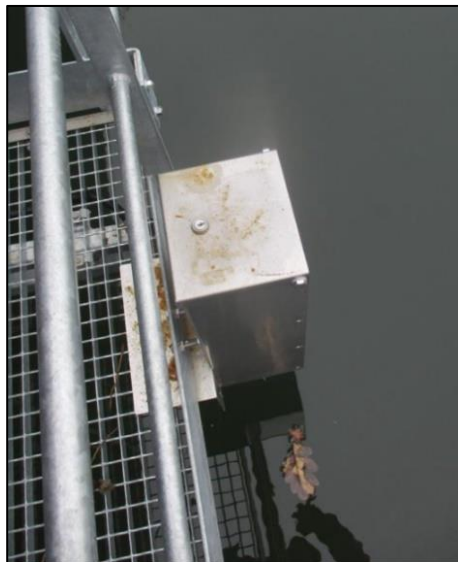
Figure 30 : Sonde de niveau / compteur entrée-sortie des bateaux type
