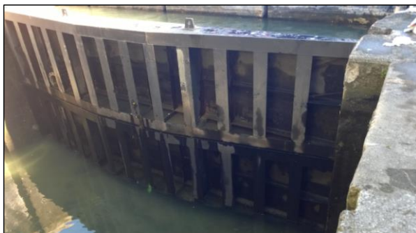
Figure 3 : Exemple de batardeau monobloc acier sur le canal St Martin pour un gabarit Freycinet
