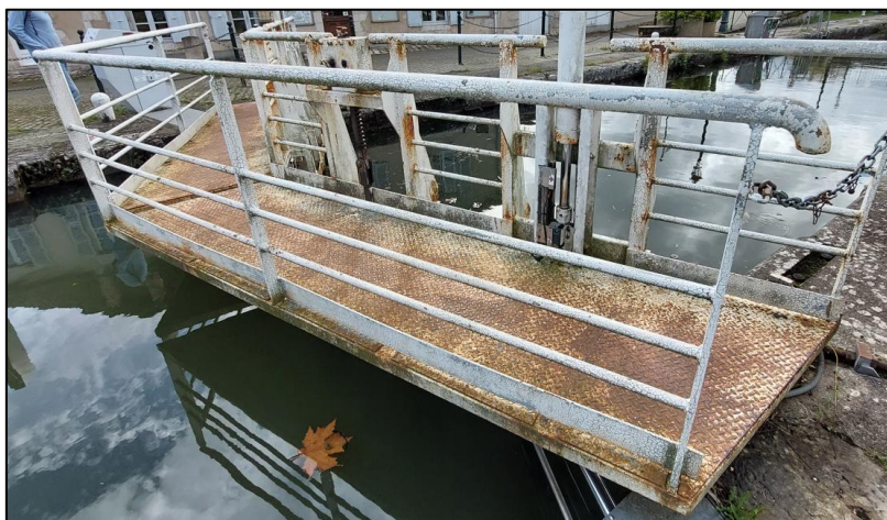
Figure 15 : Exemple de passerelle technique défraîchie à mettre en peinture (écluse n°2)
