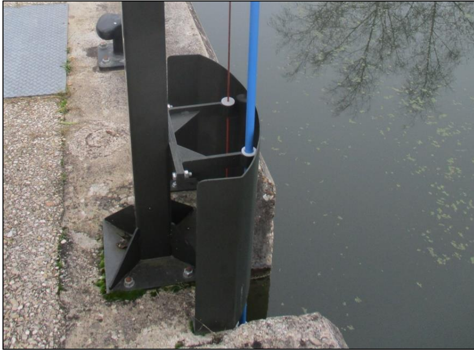
Figure 24 : Protège tirette de bassinée vu sur l'écluse n°35
