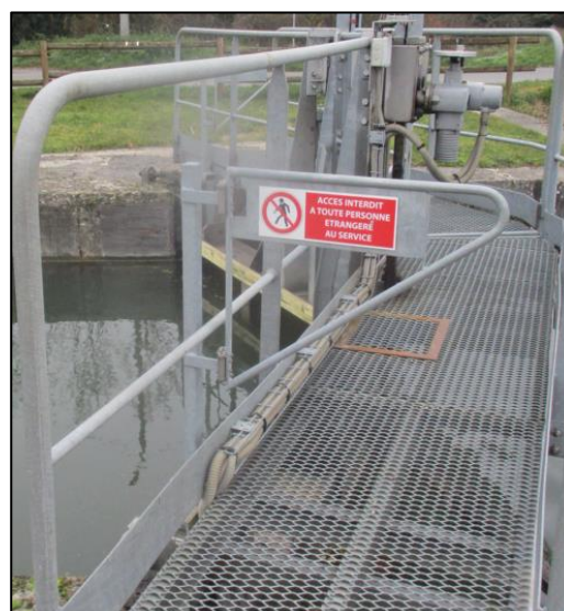
Figure 14 : Passerelle existante à rénover (à gauche), Porte saloon vue sur l'écluse n°35 (à droite)
