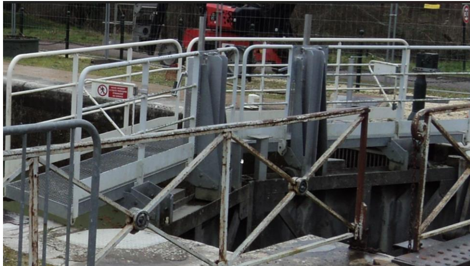
Figure 17 : Vue d'une porte équipée de rehausses de débusqueur
