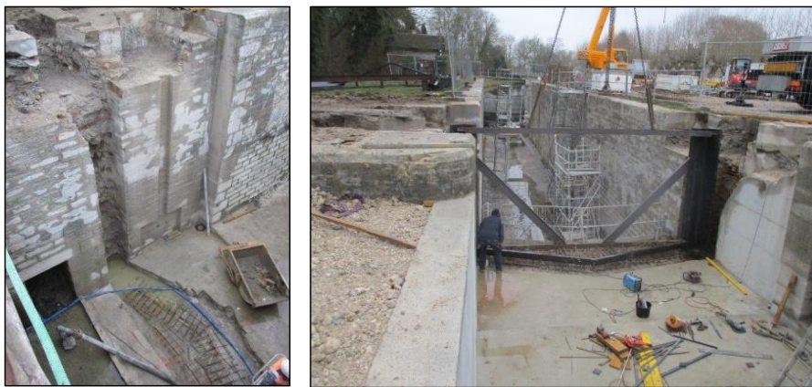
Figure 23 : Exemple de travaux de sciage en vue de l'insertion des chardonnets / faux-busc
