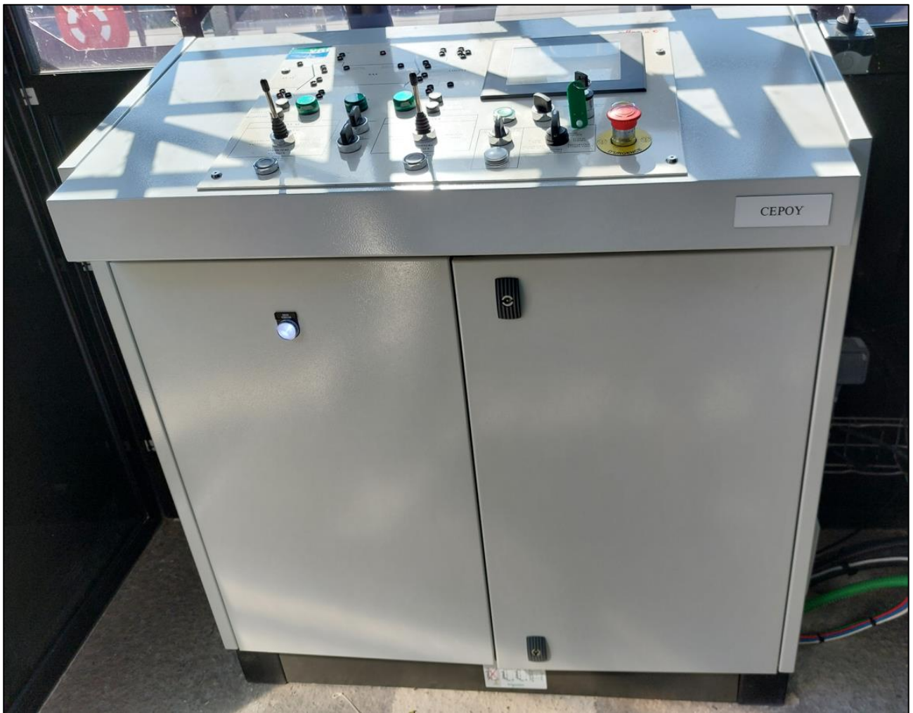
Figure 7 : Armoire de commande et pupitre
