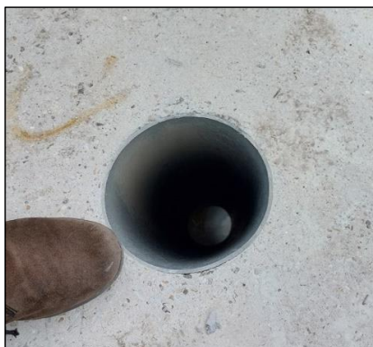
Figure 29 : Vue d'un événement (grille de fermeture non fixée)
