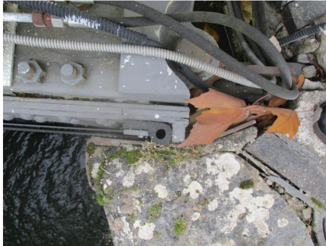
Figure 4 : Exemple d'articulation supérieur à remplacer
