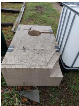
Figure 18 : Pierre taillée pour système de manœuvre de la vanne d'aqueduc (Artelia)
