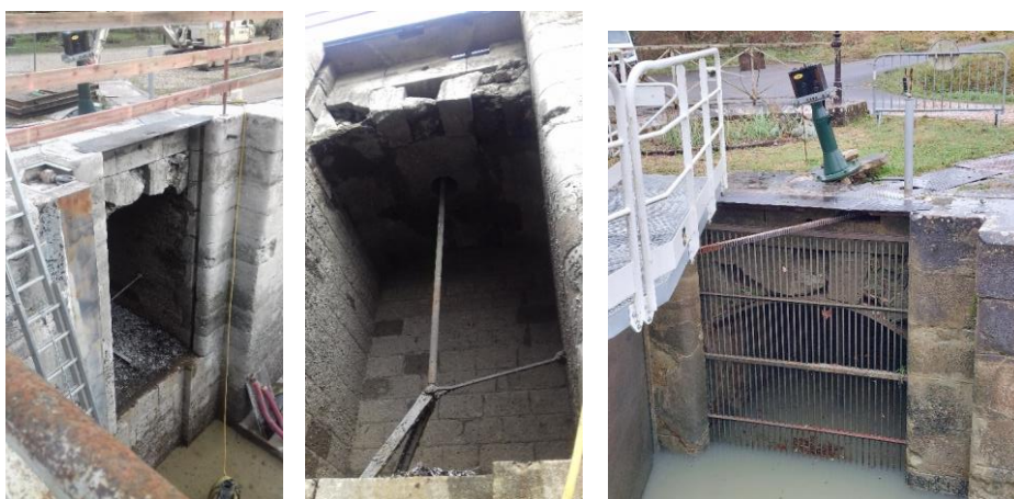
Figure 15 : Voûte de la niche d'aqueduc aval rive droite (Verchéenne | Artelia)
