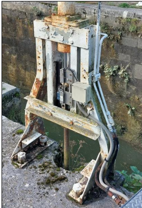
Figure 16 : Exemple de châssis support de vérin de vanne d'aqueduc défraichi à mettre en peinture
