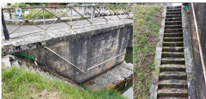
Figure 20 Escalier maçonné en aval RD
