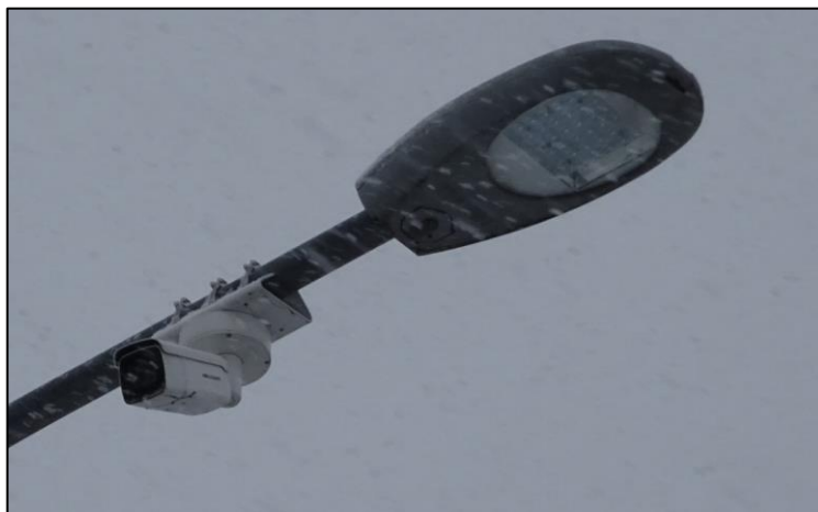
Figure 20 : Exemple d'implantation d'une caméra sur un mât d'éclairage (site VNF d'Epinal)
