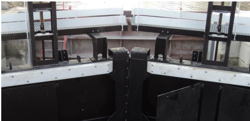
Figure 18 : Vue d'une porte non-équipée de rehausses de débusqueur
