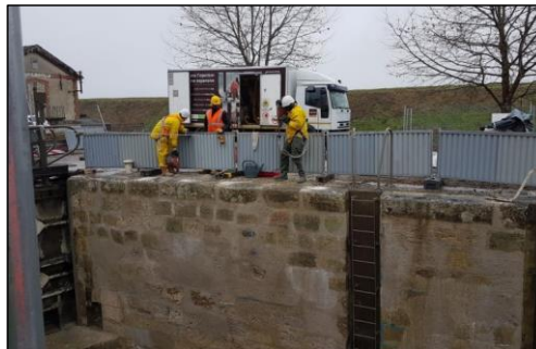
Figure 10 : travaux d'injection de résine
