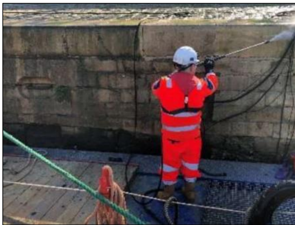
Figure 5 : Procédure de nettoyage des bajoyers
