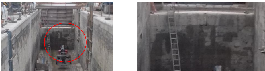
Figure 7 : Suspicion de résurgences au niveau du mur de chute (source VNF)
