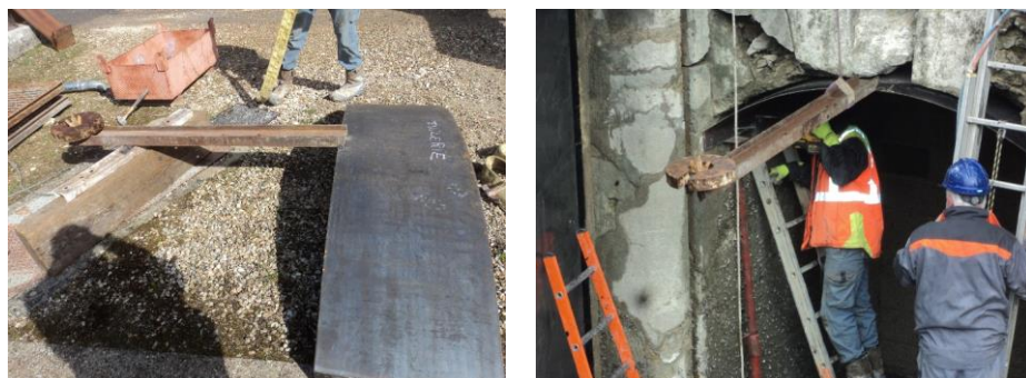
Figure 16 : Sécurisation de la voûte contre les chutes de pierres (Verchéenne)
