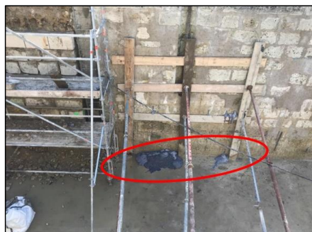
Figure 12 : résurgence de résine en pied de bajoyer d'écluse
