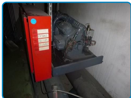
Réserve sur pièces internes non accessibles de la PAC eau/eau Sogheta TK600 de 1963 en fonctionnement
