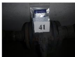
Ensemble des joints de brides amiantés
