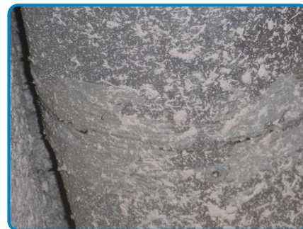
Mastic gris en jonction de conduit de ventilation
