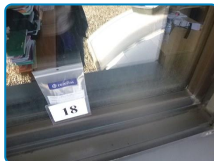
Prélèvement n° 18 : Menuiserie Mastic de vitrage côté alu (dans 2ème étage Bureau 102025)
