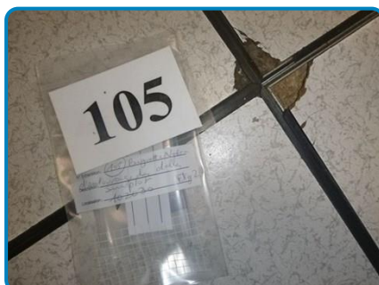
Prélèvement n° 105 : Entourage des dalles sur plot Baguette noire (dans 2ème étage Recouvrement CPAM - CAF 102030)
