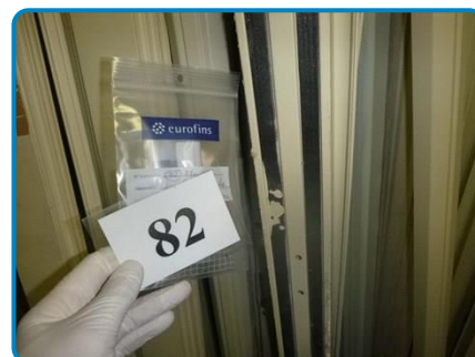
Prélèvement n° 82 : Panneaux CLESTRA HAUSSMANN Mousse d'étanchéité cloison / mur (dans Sous-sol Local stock 1S1037)
