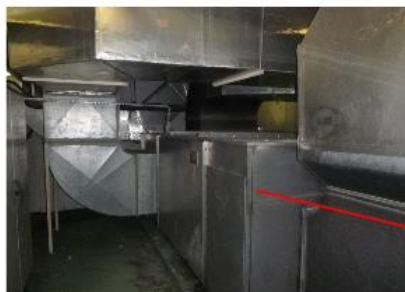
Etanchéité noire amiantée sur caisson CTA
