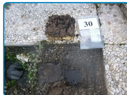
Prélèvement n° 30 : Complexe d'étanchéité Pare vapeur (sous isolant) (dans Extérieur Terrasse gravillonnée niveau 4)
