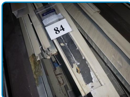
Prélèvement n° 84 : Panneaux CLESTRA HAUSSMANN Couvre joint d'angle (profil T2) Plâtre avec film bitumineux phonique (dans Sous-sol Pièce 1S1036)
