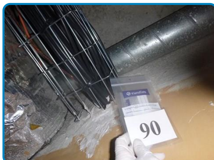
Prélèvement n° 90 : Traversée de gaine électrique Plâtre de rebouchage (dans Rez-de-chaussée WC public hall 100048)
