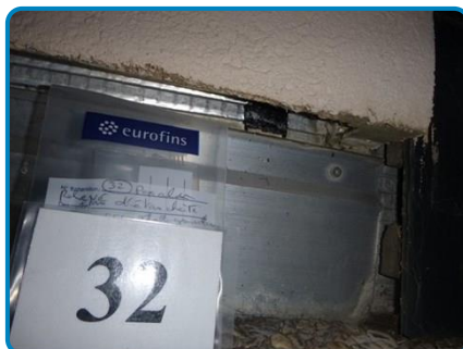
Prélèvement n° 32 : Relevé d'étanchéité Type Paxalu (dans Extérieur Terrasse gravillonnée niveau 4)
