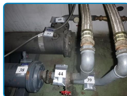
Vue générale des prélèvements (Joints de brides amiantés)
