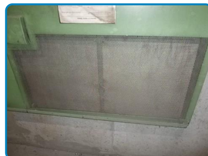
Trappe de compartimentage incendie amiantée (dans Sous-sol TGBT 1S1032)
