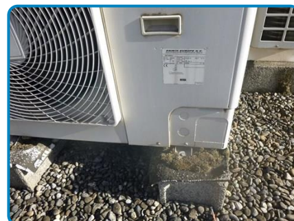
Tapis antivibratile de PAC DAIKIN de 2011 - Absence de matériau suspect
