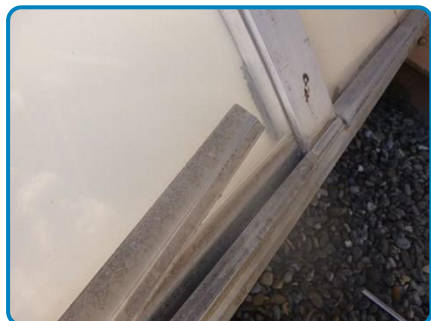
Absence de mastic de vitrage au niveau du vitrage plastique du lanterneau
