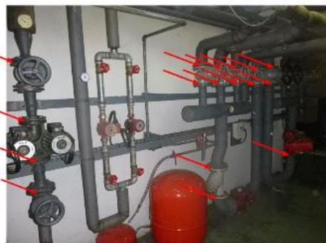
Ensemble des joints de brides amiantés
