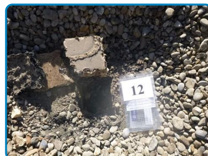
Prélèvement n° 12 : Complexe d'étanchéité Pare-vapeur (sous isolant) (dans Extérieur Terrasse étage 2)
