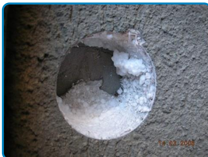
Prélèvement n° 4-D1 : Panneaux d'isolant polystyrène Colle (dans Extérieur Façade Sud Est)
