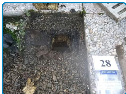
Prélèvement n° 28 : Complexe d'étanchéité Étanchéité supérieure (dans Extérieur Terrasse gravillonnée niveau 4)
