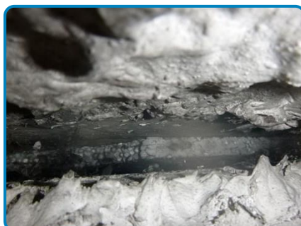
Joint de dilatation au sous-sol en polystyrène
