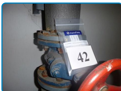
Prélèvement n° 42 : Vanne avant circulateur PAC Joint de bride (dans Sous- sol Chaufferie 1S1016)
