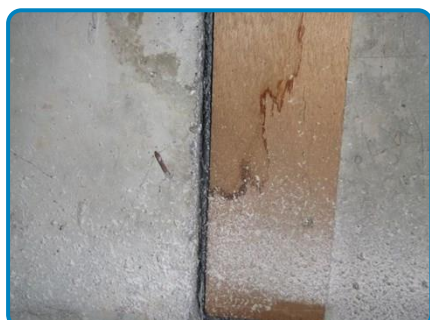
Tresse coupe feu entre étages amiantée visible au rez-de-chaussée
