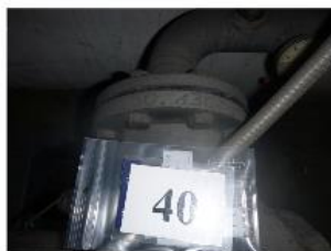
Ensemble des joints de brides amiantés
