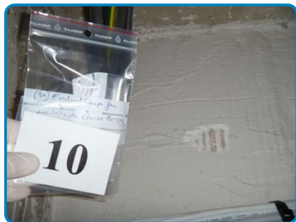
Prélèvement n° 10-D2 : Tête de cloison brique Enduit coupe-feu (dans 1er étage Salle de réunion 101033)
