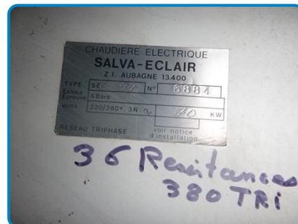
Plaque chaudière électrique SALVA-ECLAIR TYS SEG84 70KW
