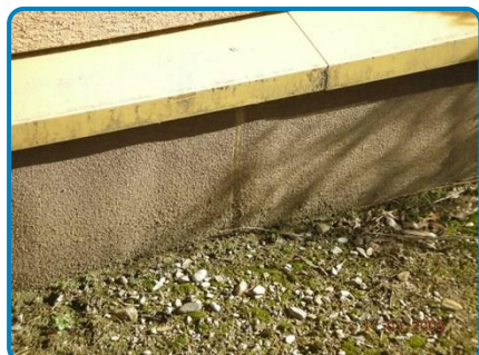
Prélèvement n° 9/D1 : Remontée d'étanchéité Revêtement bitumineux (dans Extérieur Façade Nord Ouest)
