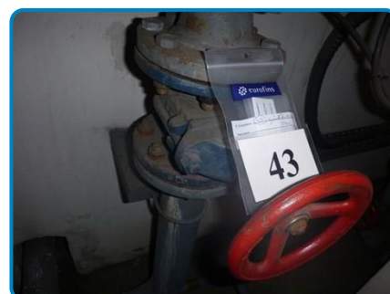
Prélèvement n° 43 : Circulateur PAC Joint de bride (dans Sous-sol Chaufferie 1S1016)
