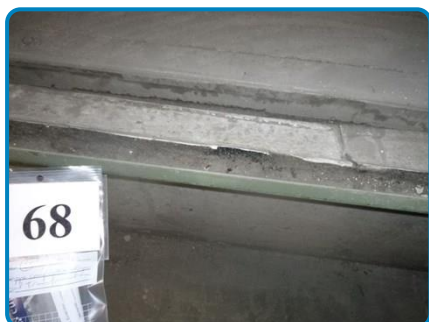
Prélèvement n° 68 : Trappe de compartimentage incendie Joint bas (dans Sous-sol TGBT 1S1032)
