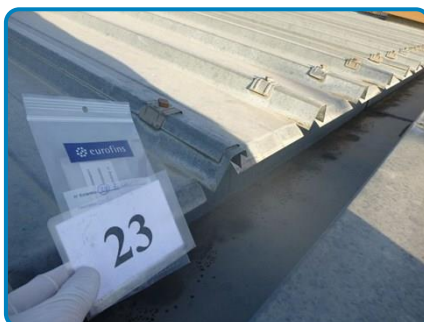
Prélèvement n° 23 : Sous-face de bac métal Revêtement anti-condensation (dans Extérieur Toit niveau 5)
