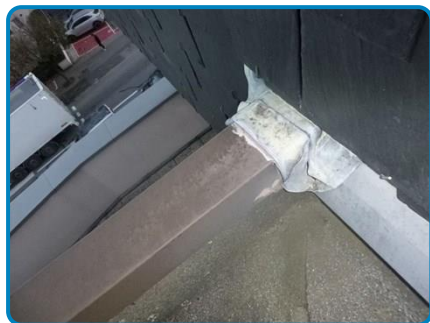
Bavette d'étanchéité = plomb
