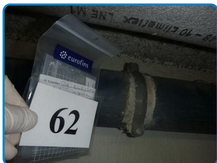
Prélèvement n° 62 : Conduit Bande plâtrée + laine de verre sous collier de fix (dans Sous-sol Chaufferie 1S1016)
