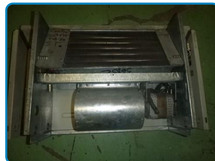
Ventilo-convecteur CIAT SILENTHERY déposé et entreposé dans le local chaufferie
