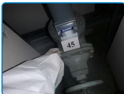
Prélèvement n° 45 : Chaudière électrique Joint de bride (dans Sous-sol Chaufferie 1S1016)
