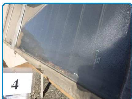
Prélèvement n° 4 : Panneau solaire Mastic de vitrage (dans Extérieur Terrasse étage 2)
