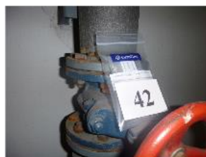
Ensemble des joints de brides amiantés
