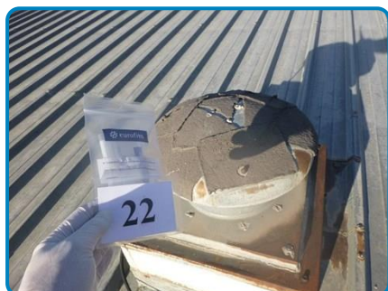
Prélèvement n° 22 : Tourelle d'extraction Plaque bitumineuse (dans Extérieur Toit niveau 5)
