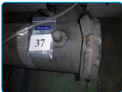
Prélèvement n° 37 : Evaporateur PAC Calorifuge mousse (dans Sous-sol Chaufferie 1S1016)
