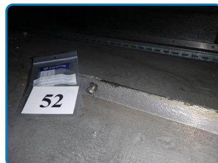
Prélèvement n° 52 : Caisson CTA Étanchéité noire (dans Sous-sol Chaufferie 1S1016)
