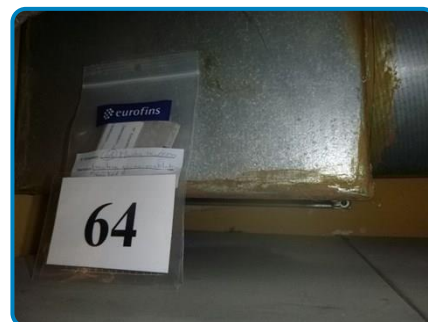
Prélèvement n° 64 : Gains de ventilation métal Mastic marron de jonction (dans Sous-sol Circulation 1S1022)
