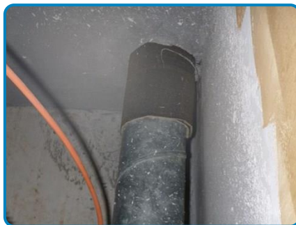
Entourage de gaine en traversée de mur (plenum WC)
