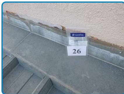
Prélèvement n° 26 : Solin de machinerie ascenseur Étanchéité (dans Extérieur Toit niveau 5)
