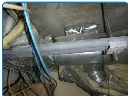
Calorifuge laine de verre de gaine de ventilation
