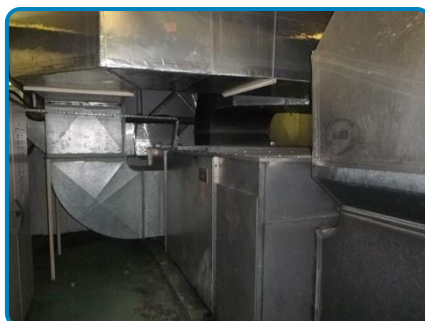
Caisson CTA avec étanchéité noire amiantée - Réserve sur pièces internes non accessibles de la CTA en fonctionnement
