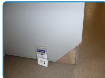
Prélèvement n° 94 : Porte coupe feu Âme bois aggloméré (dans Rez-de-chaussée Dégagement 100047)
