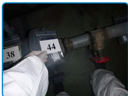
Prélèvement n° 44 : PAC Filasse et pâte à joint (dans Sous-sol Chaufferie 1S1016)
