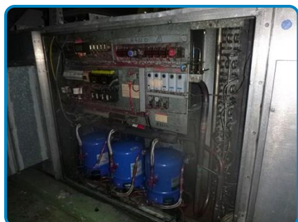
Armoire de commande CTA
