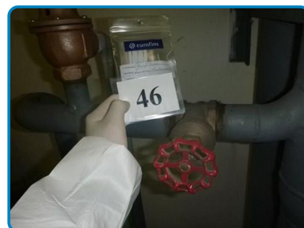
Prélèvement n° 46 : Vanne de départ Chaudière électrique Filasse et pâte à joint (dans Sous-sol Chaufferie 1S1016)
