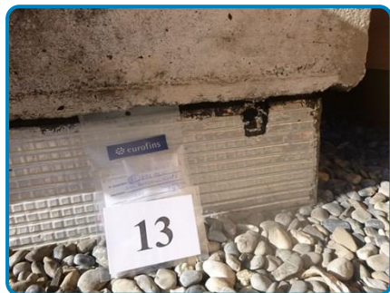
Prélèvement n° 13 : Boisseau de ventilation Paxalu (dans Extérieur Terrasse étage 2)
