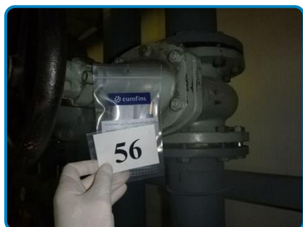
Prélèvement n° 56 : Circuit de chauffage Joint de bride départ (dans Sous-sol Chaufferie 1S1016)
