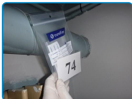
Prélèvement n° 74 : Traversée de mur Entourage de conduit Complexe laine de verre / bitume (dans Sous-sol Sanitaires)
