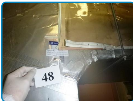
Prélèvement n° 48 : Gains de ventilation CTA Scotch alu de jonction (dans Sous-sol Chaufferie 1S1016)
