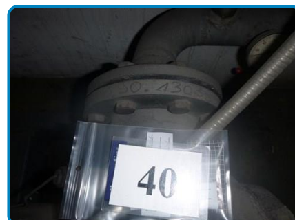
Prélèvement n° 40 : Pompe A Chaleur Joint de bride (dans Sous-sol Chaufferie 1S1016)
