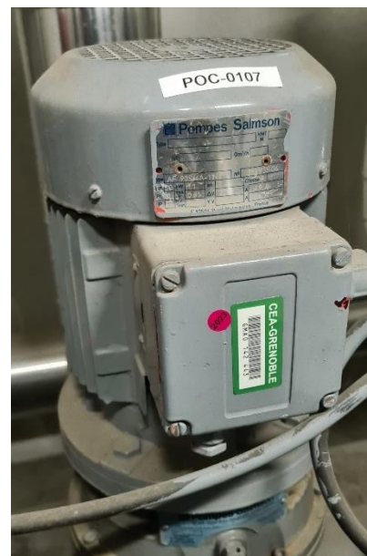
Ref GED CEA : POC0107 Marque : SALMSON Modèle : AF 90S 4A-11N Type : pompe simple
