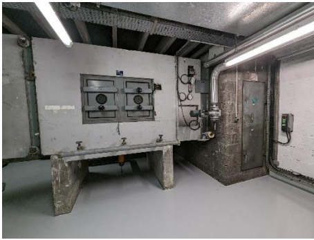
Vue d'ensemble gaines air neuf + groupe moto ventilateur
