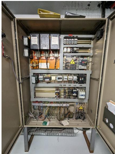
Armoire force à remplacer
