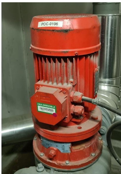
Ref GED CEA : POC0106 Marque : SALMSON Modèle : BM-LRC/JRC408-16/1.1 Type : pompe simple
