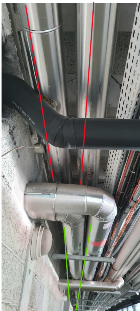
Aile A-B : Les réseaux eau surchauffée (en rouge) et les réseaux eau glacée (en vert) seront déposés dans leur intégralité.
