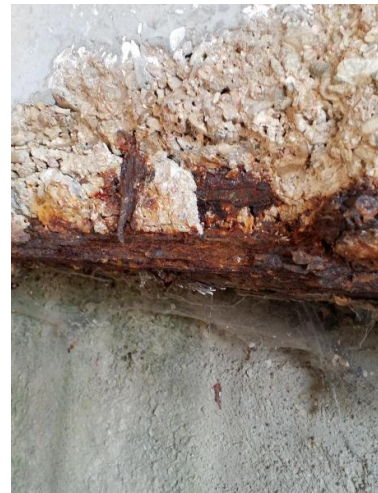
Photo n° 36 : E0 vers D63 oxydation des fers
