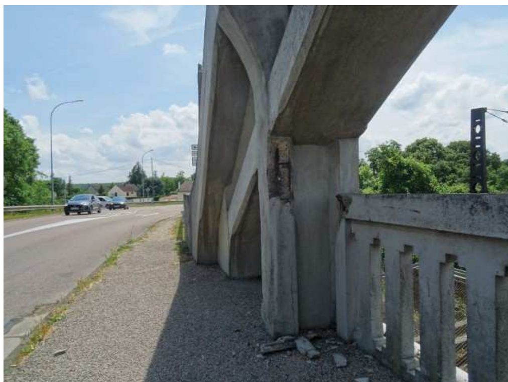
Photo n° 7 : Côté Ouest, suspente n°10. 1 éclat sur fer feuilleté côté Nord.
