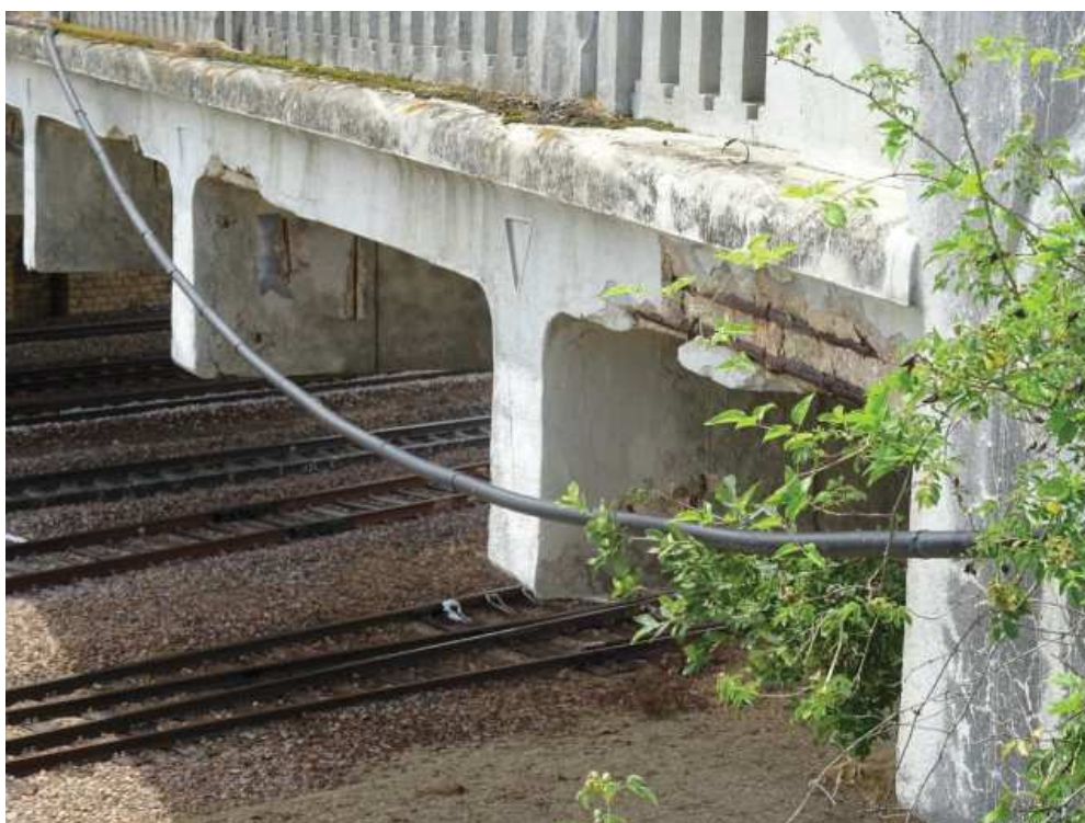
Photo n° 25 : Nombreux éclats en about d'entretoises et sur le tirant côté Est (visibles depuis le dessus).
