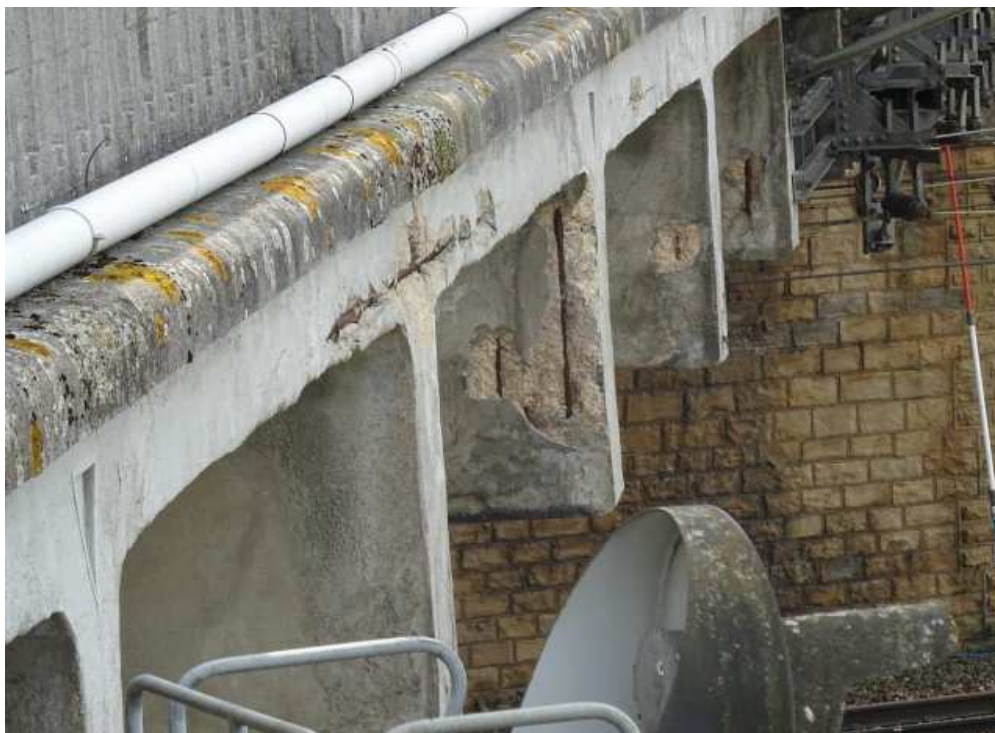
Photo n° 24 : Nombreux éclats en about d'entretoises et sur le tirant côté Ouest (visibles depuis le dessus).
