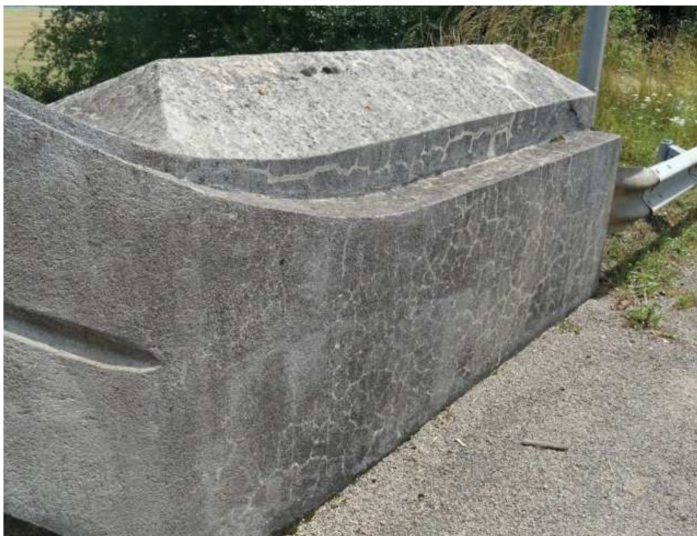
Photo n° 5 : Côté Est, culasse côté Auxerre. Faïençage côté chaussée.
