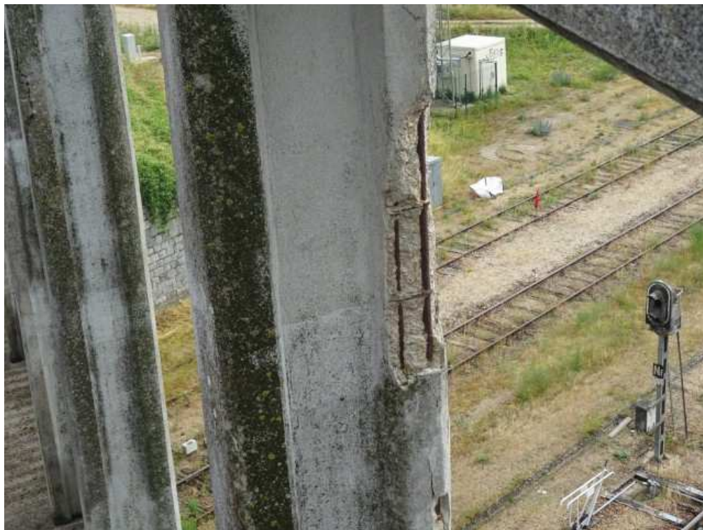
Photo n° 9 : Côté Est, suspente n°6. 1 éclat sur fer en partie supérieure face extérieure.
