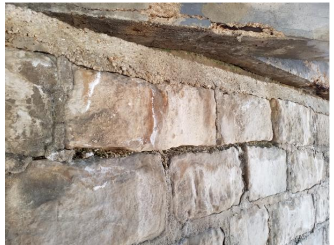
Photo n° 105 : C1 - joints creux en haut
