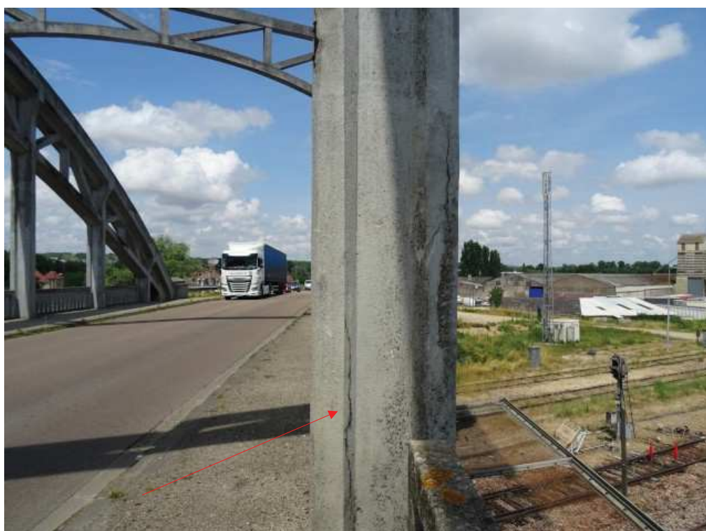
Photo n° 3 : Côté Est, suspente n°7. Eclat et début d'éclat à la base côté chaussée (130 x 6 x 6 cm 3 ).
