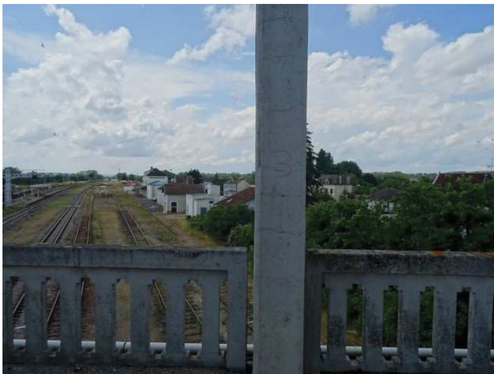
Photo n° 6 : Côté Ouest, suspente n°3. Fissures horizontales et faïençage côté chaussée sur h = 2,5 m.
