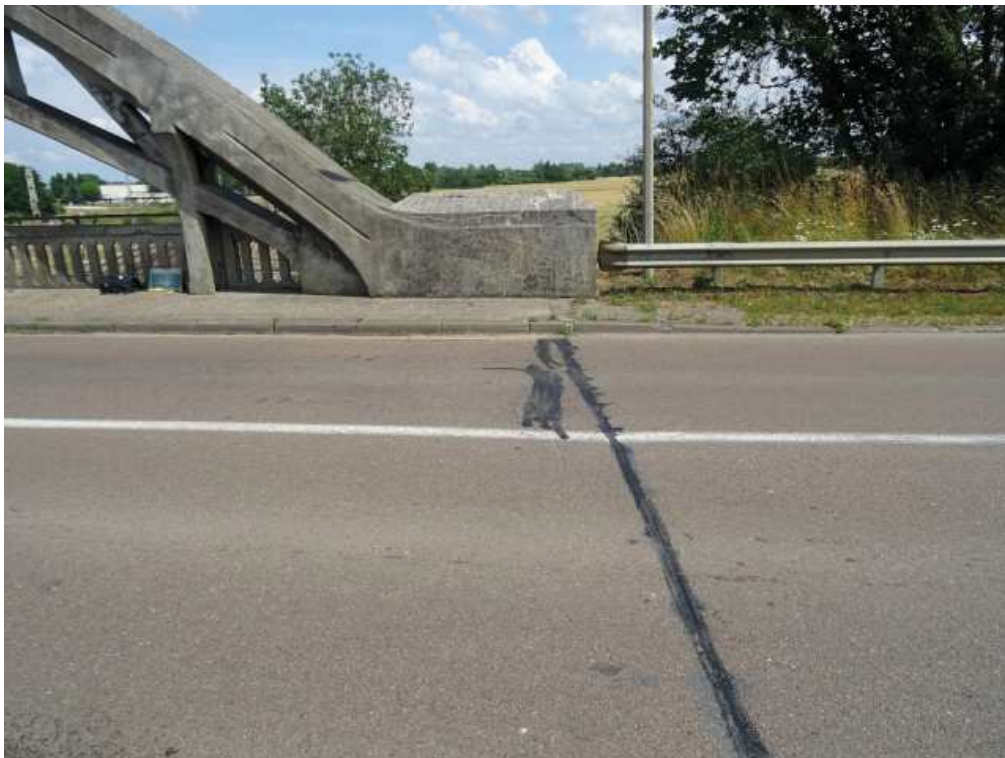
Photo n° 18 : Extrémité côté Sud. Faïençage, pontage et ornierage sur la chaussée (joint de dilatation non visible)
