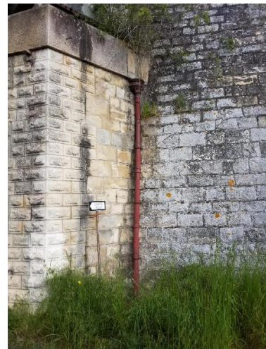
Photo n° 89 : C0 gouttière côté marseille avant nettoyage
