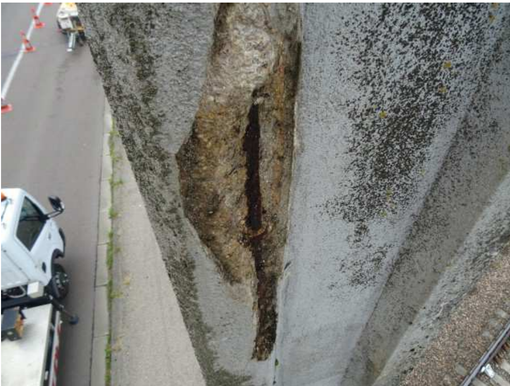
Photo n° 11 : Côté Ouest, suspente n°7. Éclat avec fers feuilletés côté Auxerre.
