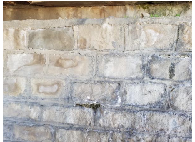
Photo n° 103 : C1 joints creux et fissure en haut
