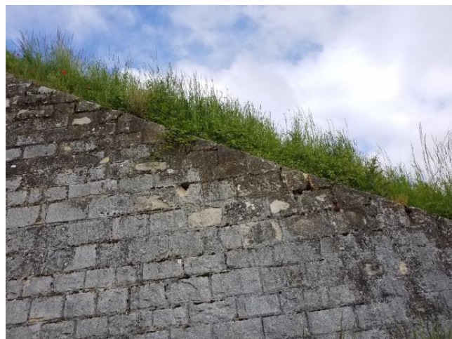
Photo n° 97 : M0G fissure sous le couronnement
