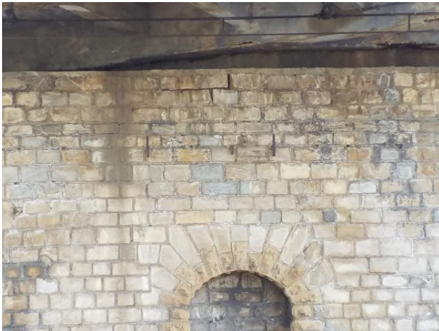
Photo n° 102 : C1 - joints creux
