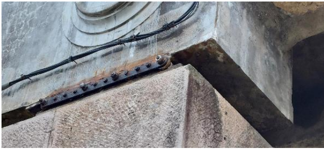
Photo n° 92 : C0 - Ecrou remplacé
