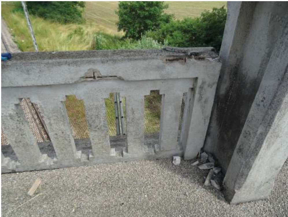
Photo n° 22 : Garde-corps côté Est, entre S9-S10. 2 éclats sur fers sur la main courante côté chaussée (à proximité de S10).
