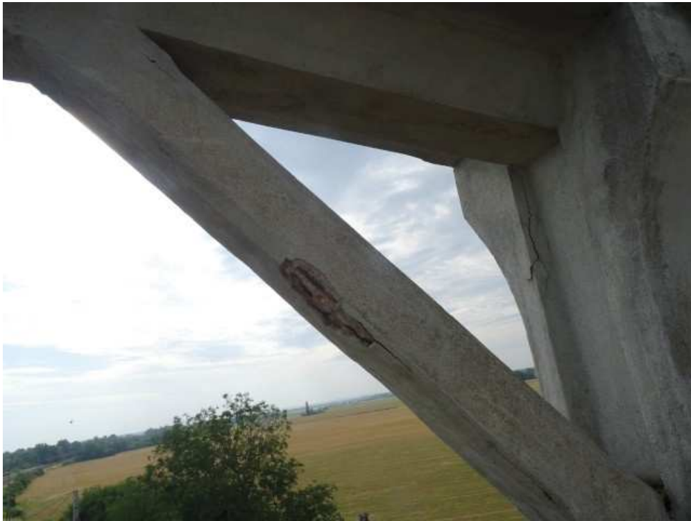
Photo n° 8 : Côté Est, renforts entre les arcs supérieur et inférieur entre S6-S7. Éclat et début d'éclat.
