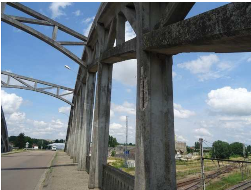
Photo n° 2 : Côté Est, suspente n°9. 1 éclat sur fer 150 x 15 x 6 cm 3 .
