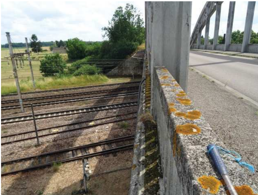
Photo n° 23 : Corniche côté Est. 1 fourreau décroché + dépôts importants.
