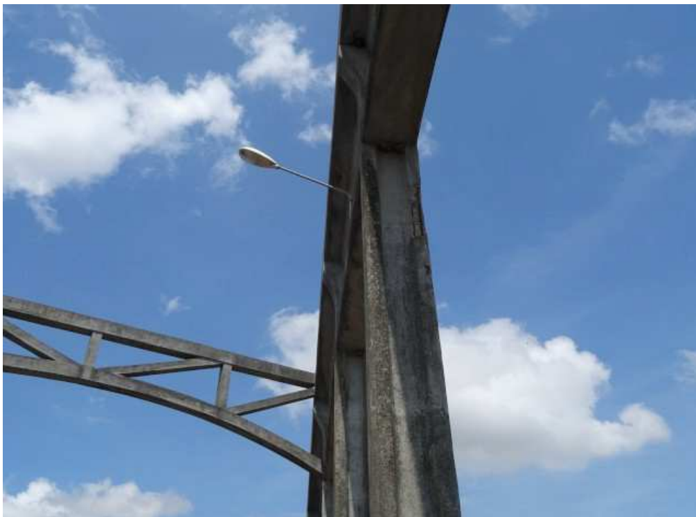
Photo n° 4 : Côté Est, suspente n°6. 1 éclat en partie supérieure face extérieure (150 x 20 x 3 cm 3 ).
