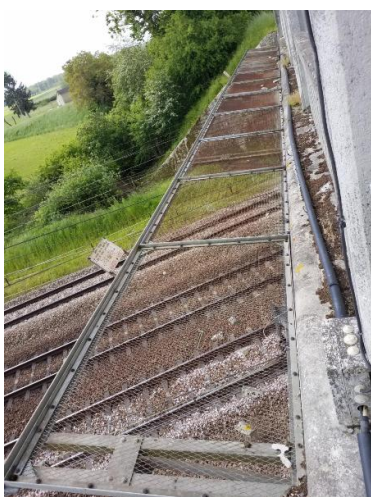
Photo n° 1 : Auvent caténaire côté Marseille
