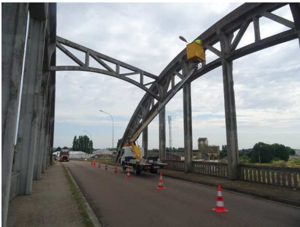
Photo n° 12 : Vue sur moyen d'inspection (nacelle positive).
