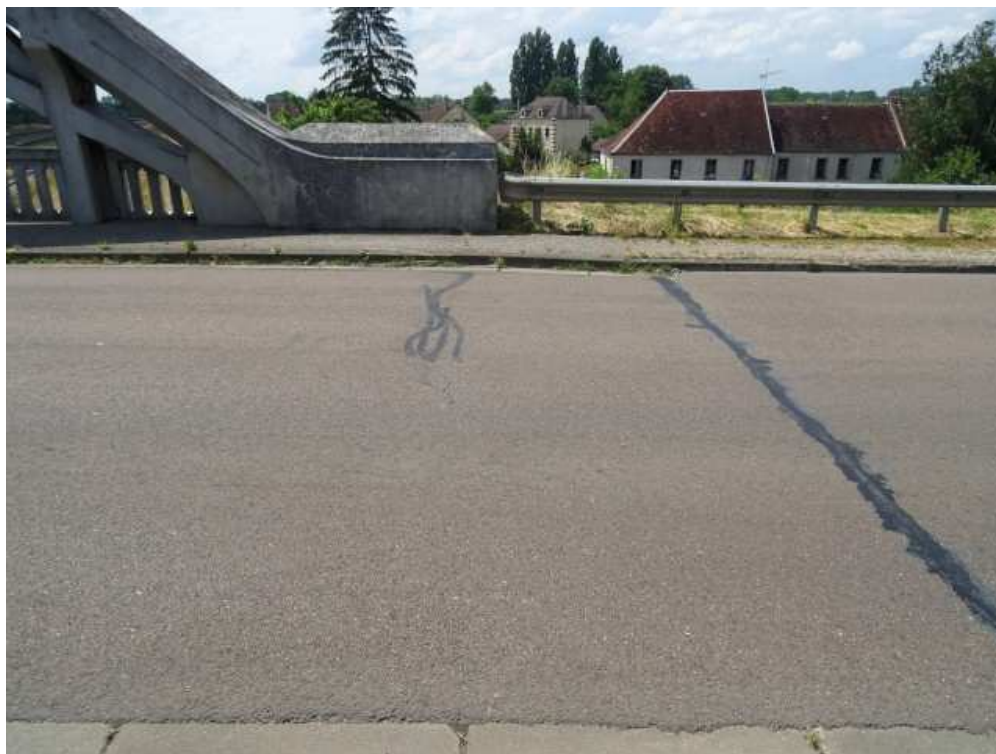
Photo n° 16 : Extrémité côté Nord. Faïençage, pontage et ornierage sur la chaussée (joint de dilatation non visible)
