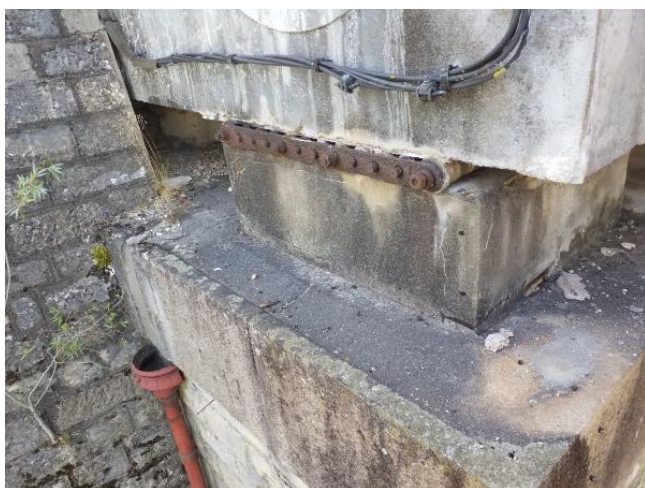
Photo n° 90 : C0 appui côté Paris avant le remplacement de l'écrou
