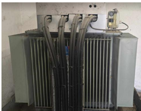
Figure 5 : Transformateur 800kVA
