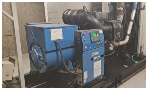
Figure 6 : Groupe Electrogène 600kVA
