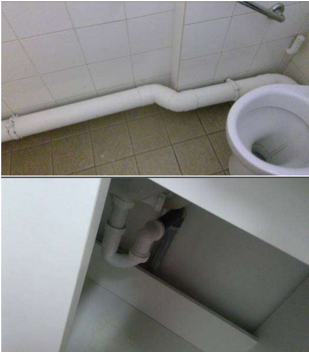
Figure 4 - Conduits intérieurs dans les locaux humides ne contenant pas d'amiante Produits qui part nature ne contient pas de fibres d'amiante.
