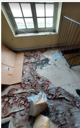
Prélèvement - P003 : R+1 / Accès étage - Dalle de sol- (Présence d'amiante)
