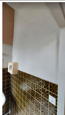
Prélèvement - P005 : Unité Pinel / R+1 / Sanitaire cadre - Enduit- (Absence d'amiante)
