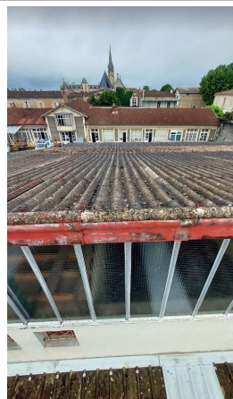
Prélèvement - P001 : R+2 / Couverture - Plaque ondulée- (Présence d'amiante)
