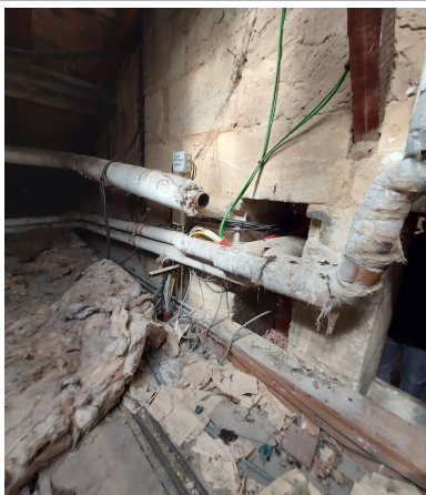
Prélèvement - P012 : R+1 / Comble 1 - Enveloppe de calorifuge - (Présence d'amiante)
