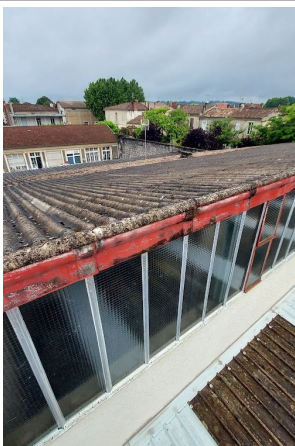
Prélèvement - P001 : R+2 / Couverture - Plaque ondulée- (Présence d'amiante)
