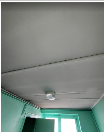
Prélèvement - P010 : R+1 / Pièce d'eau - Plaque- (Présence d'amiante)
