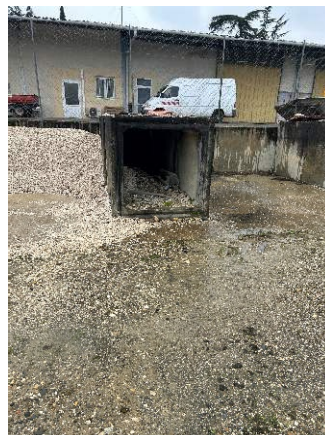
Module béton 1 m x 1 m utilisé comme caniveau
