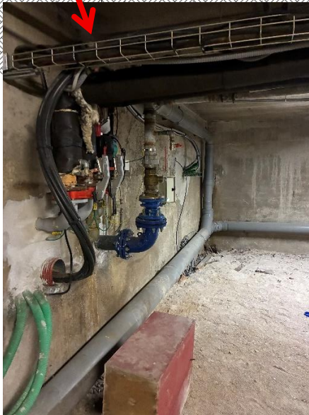
Arrivée : Electricité Eau Chauffage depuis sous-station
