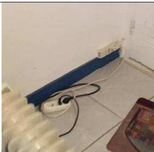
Appareillage vétuste et sur rallonges
