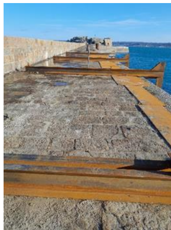
Figure 1 - Photographie des 4 tirants provisoires
