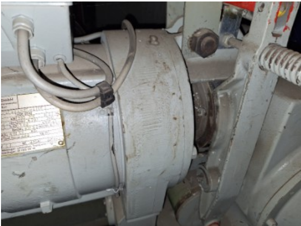
P? R+4 / Machinerie ascenseur / Frein d'ascenseur
