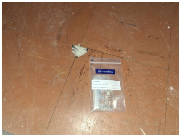
a R+2 / ZONE 13 / Dalle de sol rouge+colle [ Prélèvement n°39]
