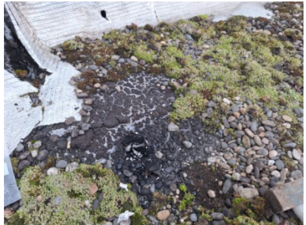
N R+3 / Toiture terrasse / Etanchéité bitumineuse [ Prélèvement n°1]
