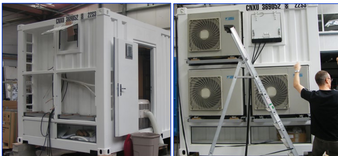
Figure 3 : Exemple d'emplacements encastrés avec montage sur glissière
