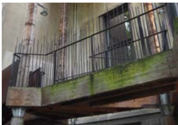
Altération à la surface des poutres bois - 2023
