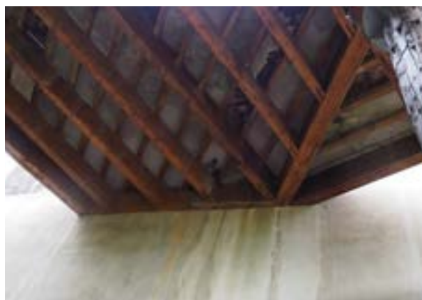
Altération de la sous-face des paliers mixtes bois métal - 2023
