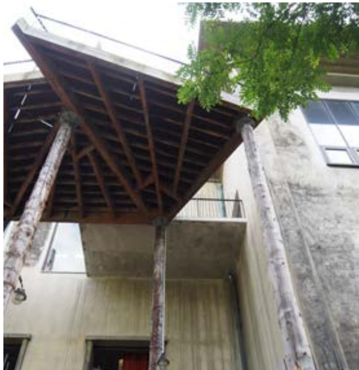
4. Ossature bois de l'escalier vue du dessous et plateforme haute en béton
