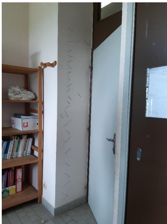
Vue de fissures sur une face arrière d'un placard de rangement, cette paroi apparaît comme étant une cloison
