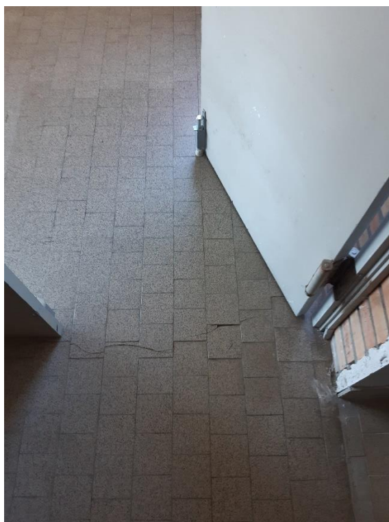
Vue d'une fissure à la jonction entre deux couloirs de circulation, celle-ci est probablement due à la différence de matériaux en sous-face (jonction dalle BA / poutrelles entrevous)
