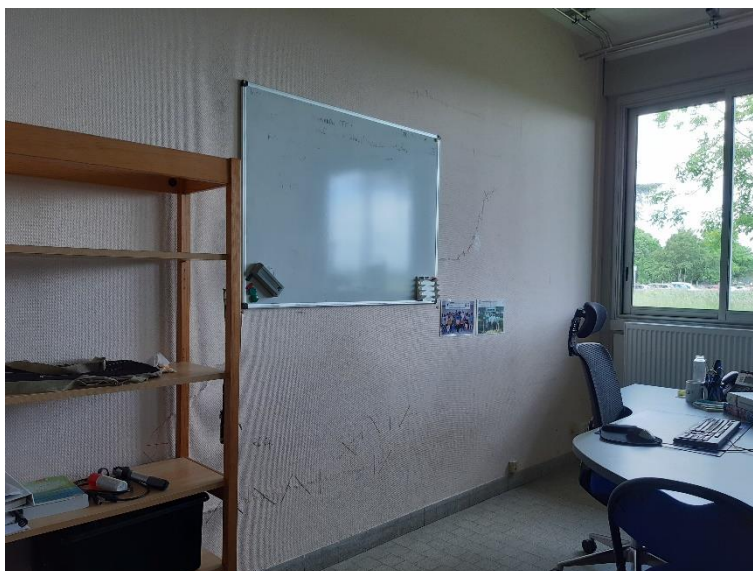
Vue de fissures sur une cloison, il n'a pas été constaté de vide-sous plinthe
