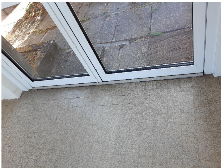
Vue d'une fissure proche d'une baie, celle-ci est probablement due à la différence de matériaux en sous-face (pleine terre / dalle BA) ou à l'absence d'armatures anti-fissuration
