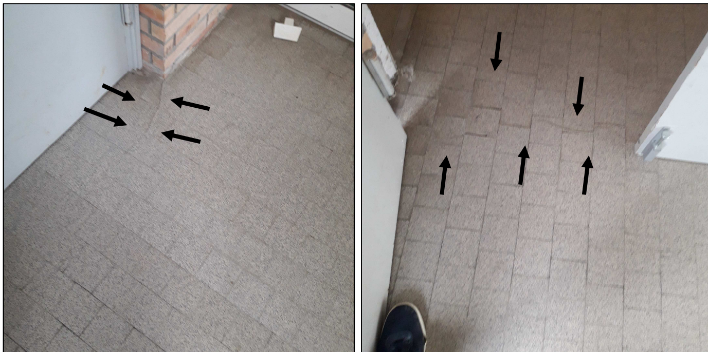
Fissures au sol dans le couloir central
