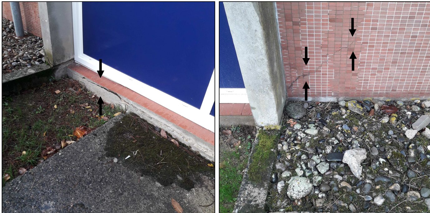
Fissuration des façades des coursives
