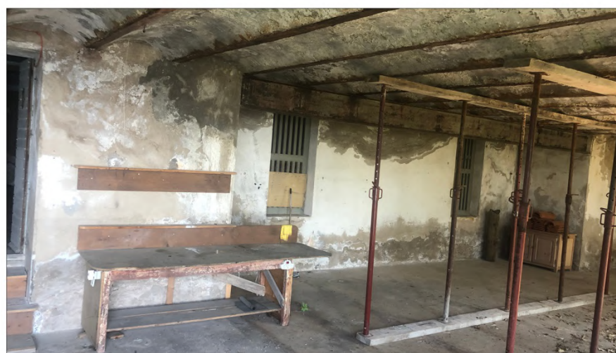
Détail - Voutains dégradés, traces d'humidité et ajouts de ciment
