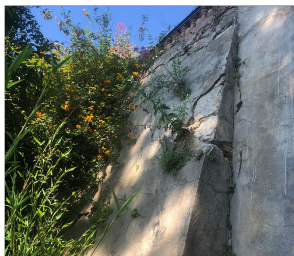
Détail - fruit du mur de soutènement
