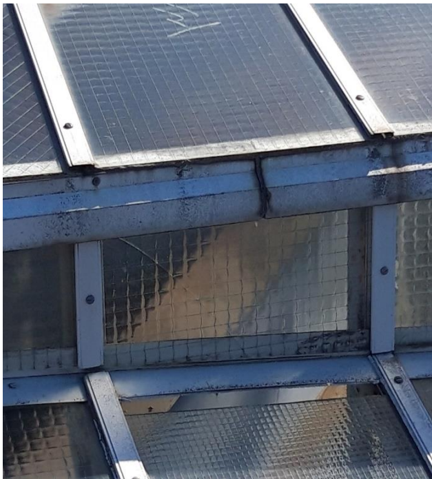
5 – Absence de recouvrement des profilés avec présence de vide – défaut d'étanchéité et infiltrations
