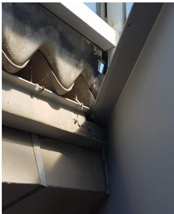
10- Infiltrations d'eau à travers orifices sur toiture fibro
