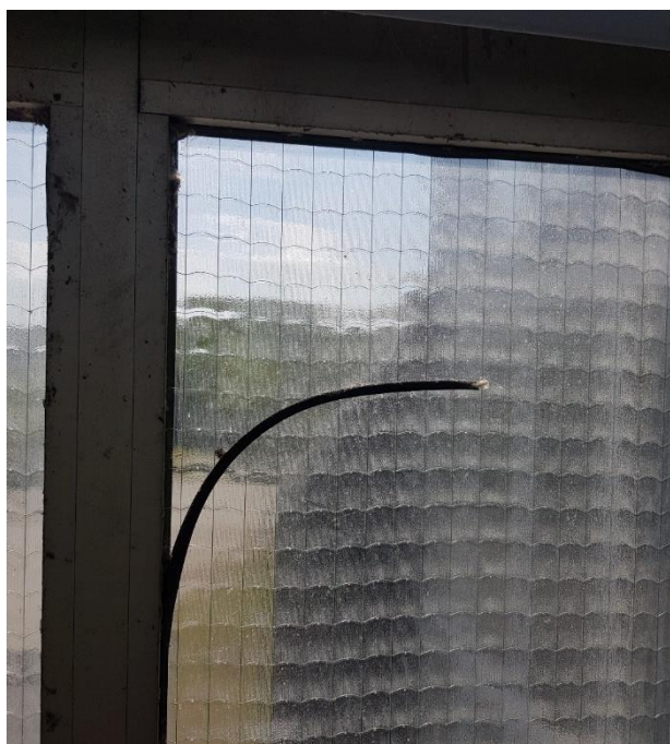
12- Joints des châssis usés à remplacer
