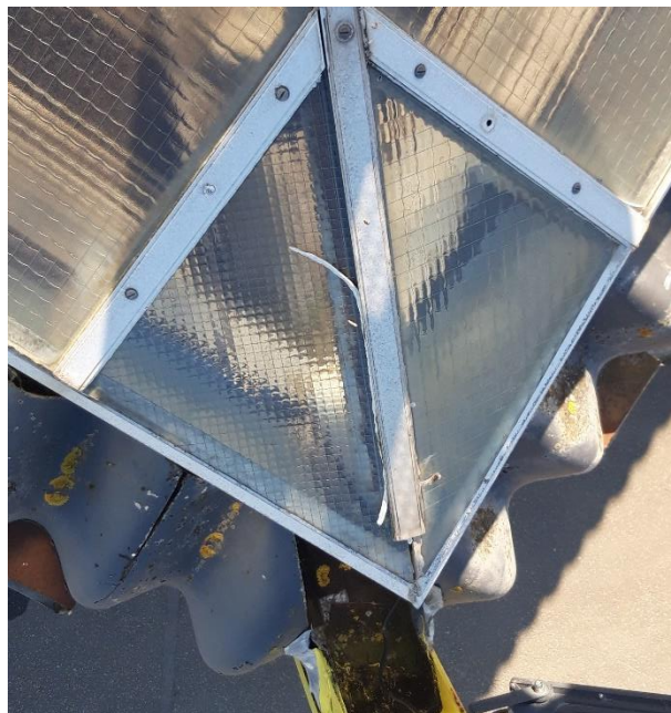
3- Joints et agrnitures en mauvais état → défaut d'étanchéité et infiltration
