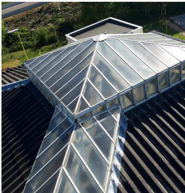
5 – Absence de recouvrement des profilés avec présence de vide – défaut d'étanchéité et infiltrations
