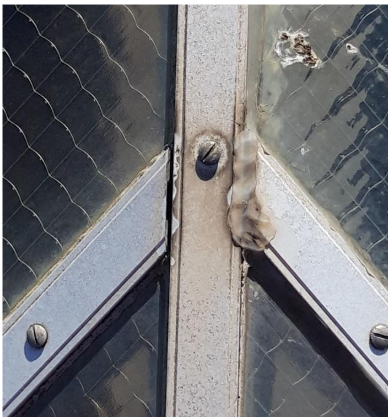
4 – Rustines suite usure des garnitures d'étanchéité avec infiltrations et désolidarisation des profilés + fixations à resserrer
