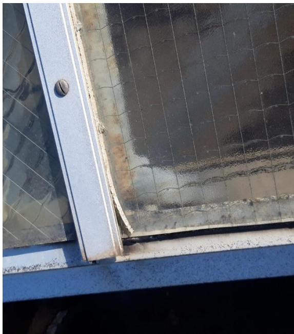
3- Joints et agrnitures en mauvais état → défaut d'étanchéité et infiltration
