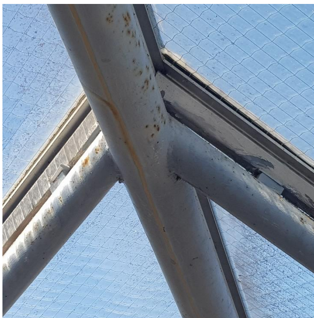
11- Calage des vitrages à inspecter et remplacer les éléments bois usés
