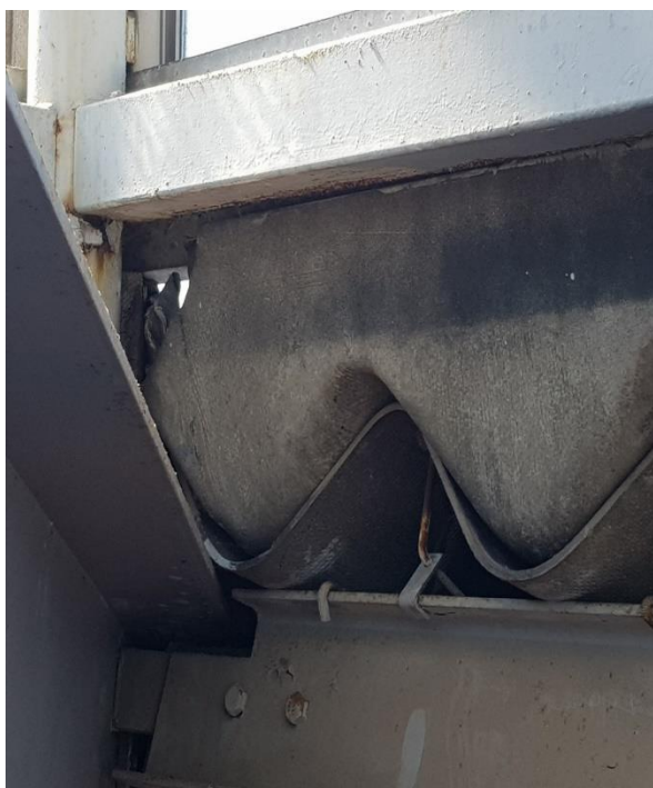
10- Infiltrations d'eau à travers orifices sur toiture fibro
