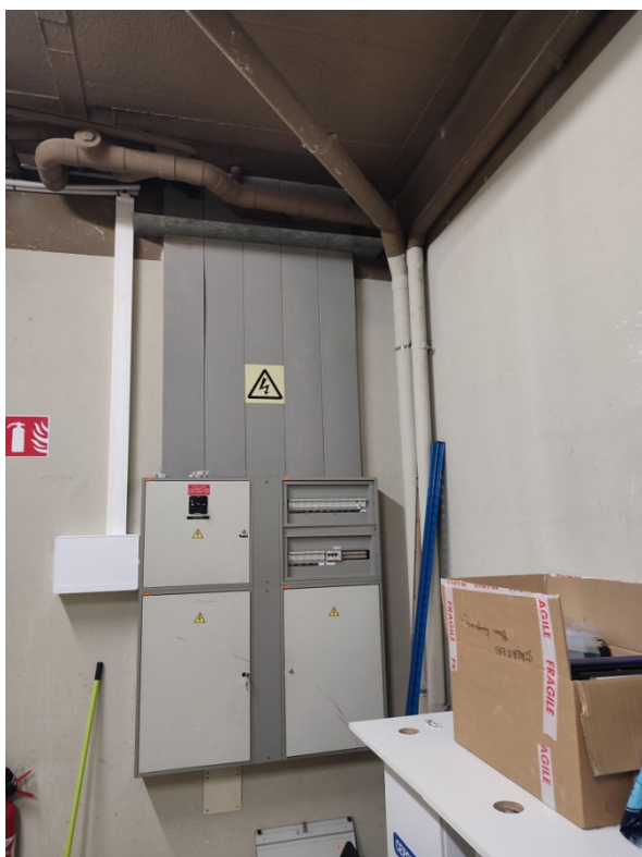
Figure 28 TGBT A PROTEGER PAR ARMOIRE CF 1H
