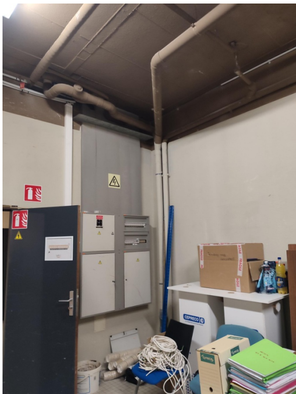
Figure 27 TGBT A PROTEGER PAR ARMOIRE CF 1H
