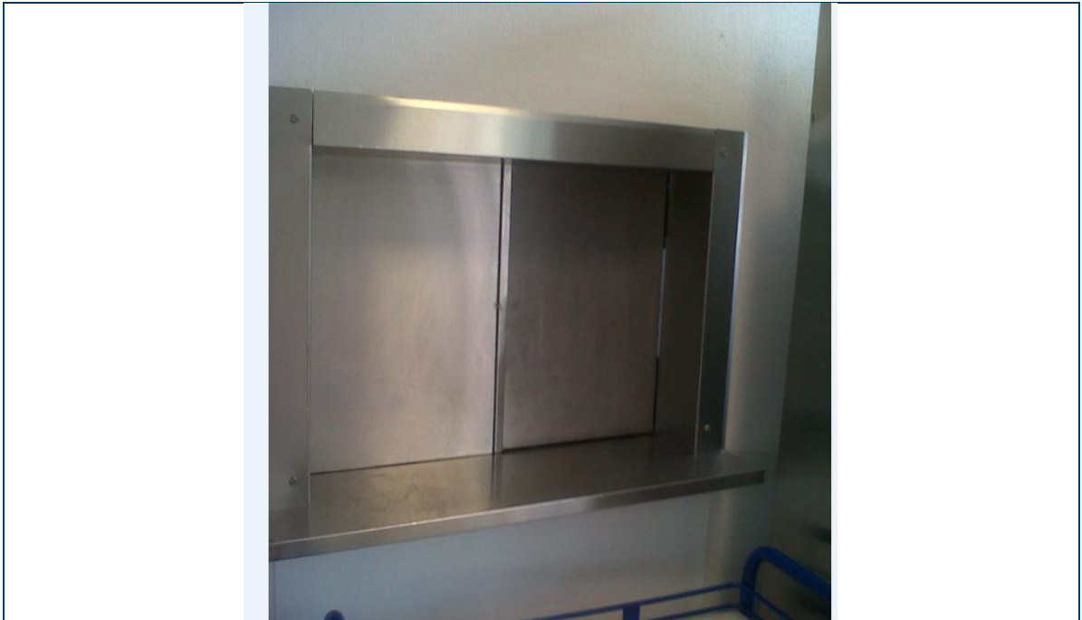
PHOTO : Passe-plat à modifier avec guillotine asservie
