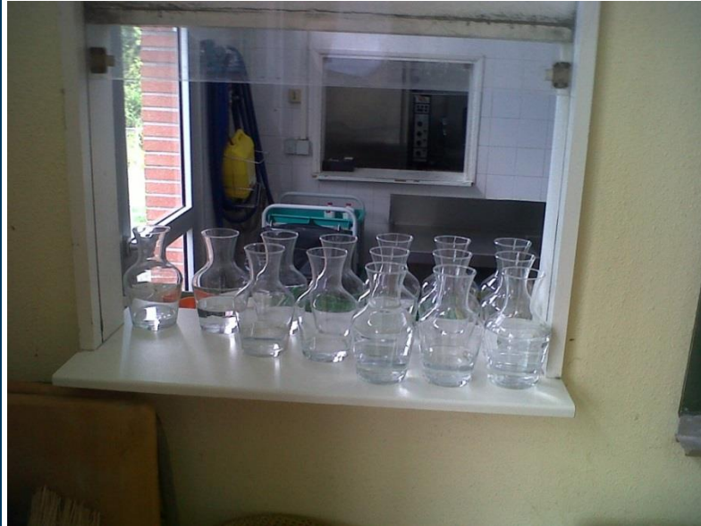
PHOTO : Passe-plat à modifier avec guillotine asservie
