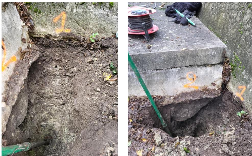
Photographies des sondages de reconnaissance de fondation PU1 et PU2 effectués au niveau du mur n°2 en maçonnerie de pierres et au niveau de l'emmarchement
