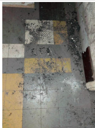
Prélèvement - P002 : RDC / Entrée - Colle de carrelage- (Absence d'amiante)
