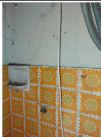
Prélèvement - P034 : RDC / Garage - Colle de faïence- (Présence d'amiante)
