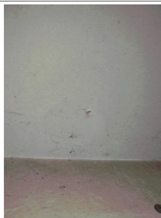
Prélèvement - P012 : RDC / Entrée - Enduit- (Absence d'amiante)
