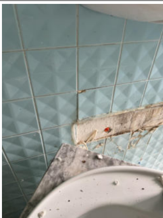
Prélèvement - P015 : R+1 / SDB - Colle de faïence- (Absence d'amiante)
