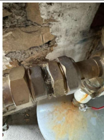
Prélèvement - P026 : Sous-sol / Garage - Joint- (Absence d'amiante)
