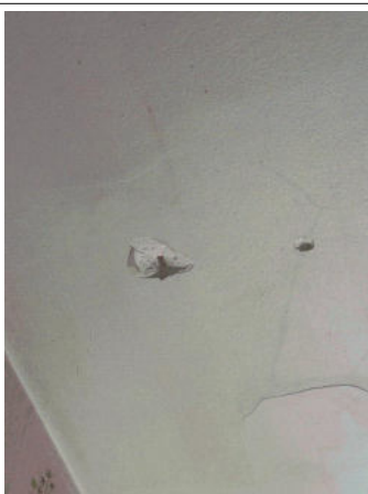
Prélèvement - P009 : R+1 / Entrée - Enduit- (Absence d'amiante)
