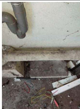
Prélèvement - P032 : RDC / Garage - Conduit- (Présence d'amiante)
