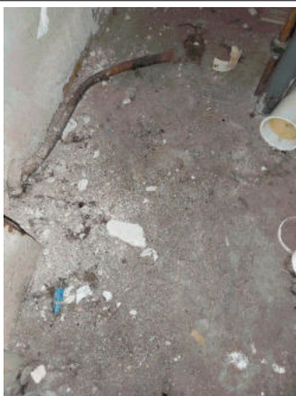
Prélèvement - P005 : RDC / Entrée - Ragréage- (Absence d'amiante)
