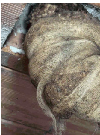
Déclaré - : Sous-sol / Garage - Calorifugeage- (Absence d'amiante)
