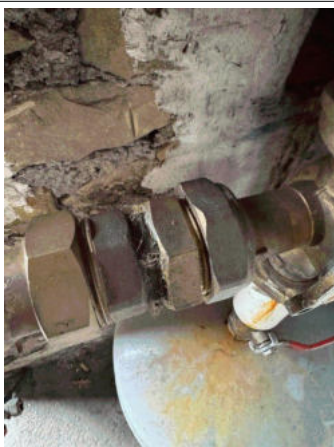
Prélèvement - P025 : Sous-sol / Garage - Joint- (Absence d'amiante)
