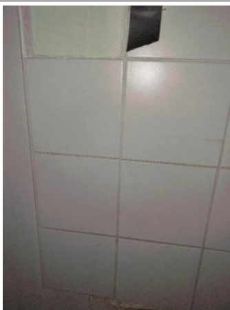
Prélèvement - P019 : RDC / SDB - Colle de faïence- (Absence d'amiante)
