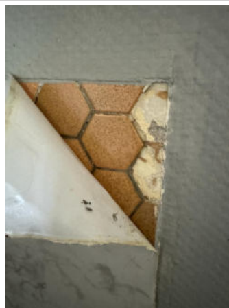
Prélèvement - P014 : R+1 / Cuisine - Colle de faïence- (Présence d'amiante)
