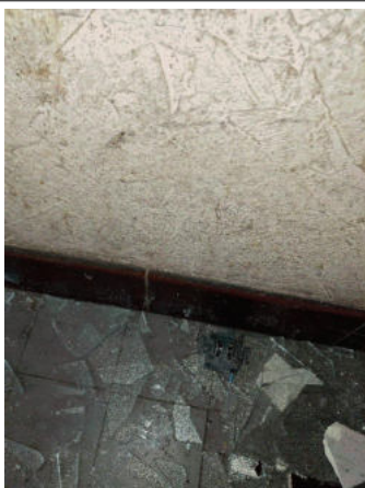
Prélèvement - P003 : RDC / Entrée - Colle de plinthe- (Absence d'amiante)
