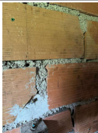
Prélèvement - P020 : Sous-sol / Garage - Joint- (Absence d'amiante)
