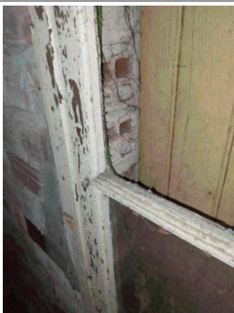
Prélèvement - P029 : Extérieur / Poulailier - Mastic- (Présence d'amiante)
