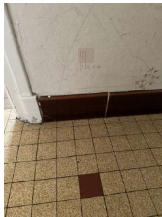
Prélèvement - P002 : R+1 / Entrée - Colle de carrelage- (Absence d'amiante)
