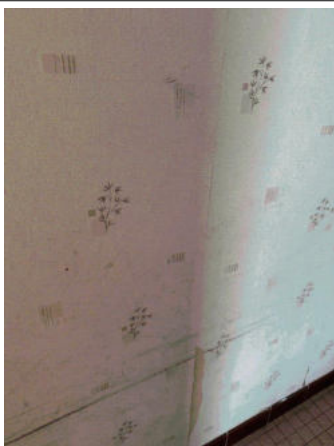
Prélèvement - P005 : R+1 / Entrée - Enduit- (Absence d'amiante)
