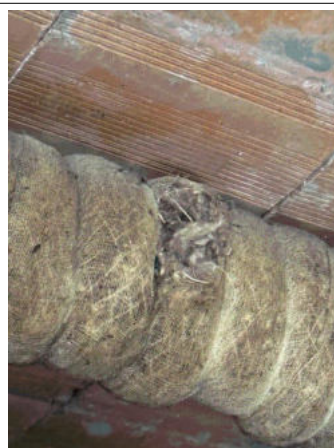
Déclaré - : Sous-sol / Garage - Calorifugeage- (Absence d'amiante)
