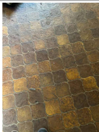
Prélèvement - P024 : Sous-sol / Garage - Lé plastique avec sous-couche- (Présence d'amiante)
