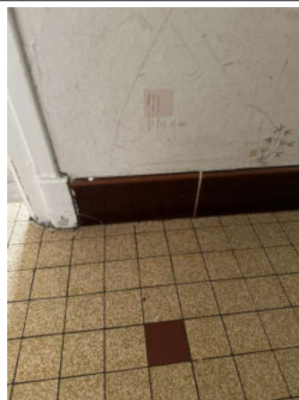
Prélèvement - P004 : R+1 / Entrée - Colle de plinthe- (Absence d'amiante)
