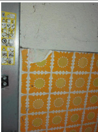
Prélèvement - P033 : RDC / Garage - Colle de faïence- (Présence d'amiante)
