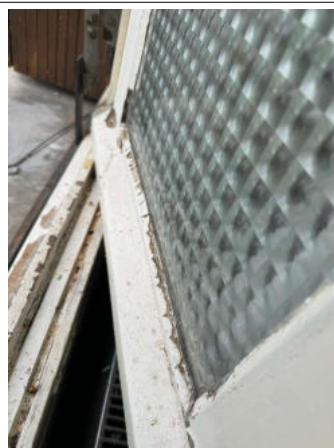
Prélèvement - P018 : R+1 / SDB - Mastic- (Absence d'amiante)
