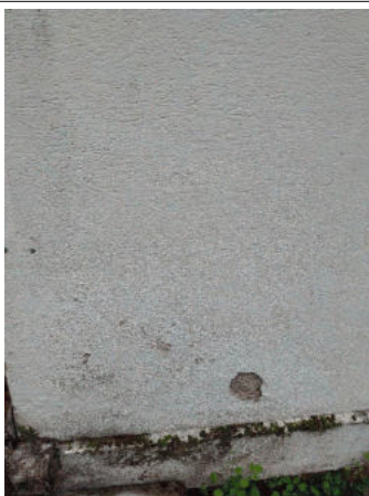
Prélèvement - P025 : Extérieur - Enduit- (Absence d'amiante)
