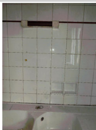
Prélèvement - P022 : RDC / Cuisine - Colle de faïence- (Présence d'amiante)
