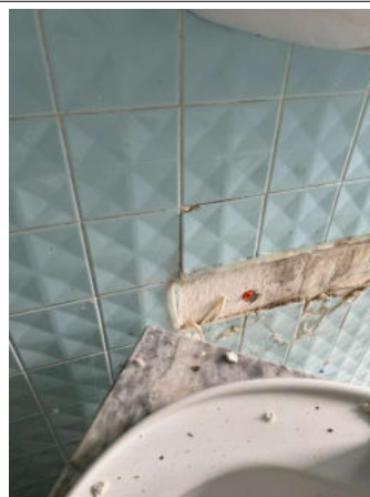
Prélèvement - P016 : R+1 / SDB - Colle de faïence- (Présence d'amiante)
