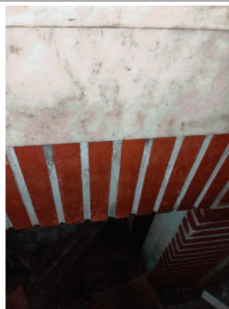
Prélèvement - P014 : RDC / Séjour - Joint de carrelage- (Absence d'amiante)
