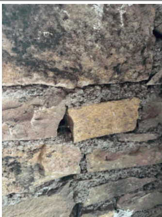
Prélèvement - P021 : Sous-sol / Garage - Joint- (Absence d'amiante)
