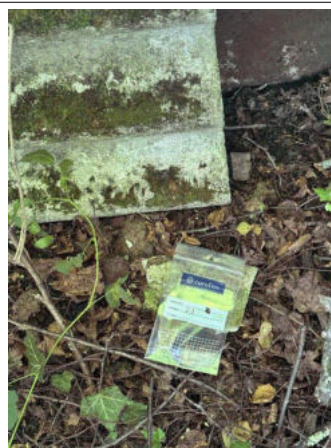
Déclaré - : Extérieur - Plaque ondulée- (Présence d'amiante)
