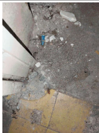
Prélèvement - P006 : RDC / Entrée - Ragréage- (Absence d'amiante)
