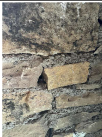
Prélèvement - P022 : Sous-sol / Garage - Joint- (Absence d'amiante)
