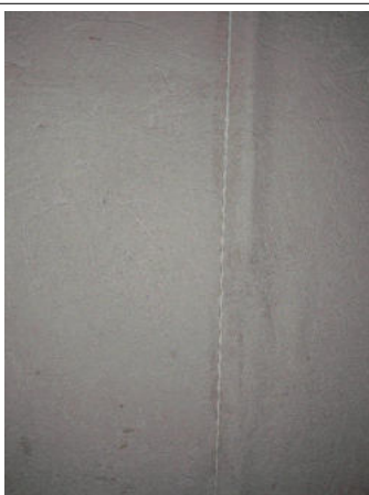
Prélèvement - P009 : RDC / Entrée - Enduit- (Absence d'amiante)
