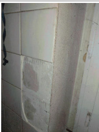
Prélèvement - P021 : RDC / Cuisine - Colle de faïence- (Présence d'amiante)
