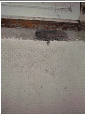
Déclaré - : RDC / Cuisine - Joint d'étanchéité entre menuiserie et ossature- (Absence d'amiante)
