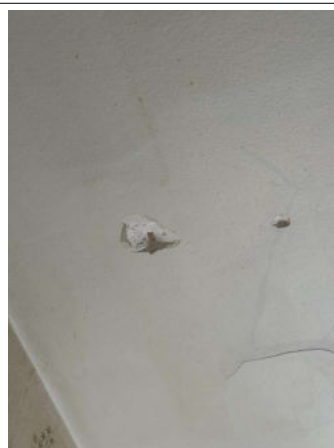
Prélèvement - P010 : R+1 / Entrée - Enduit- (Absence d'amiante)
