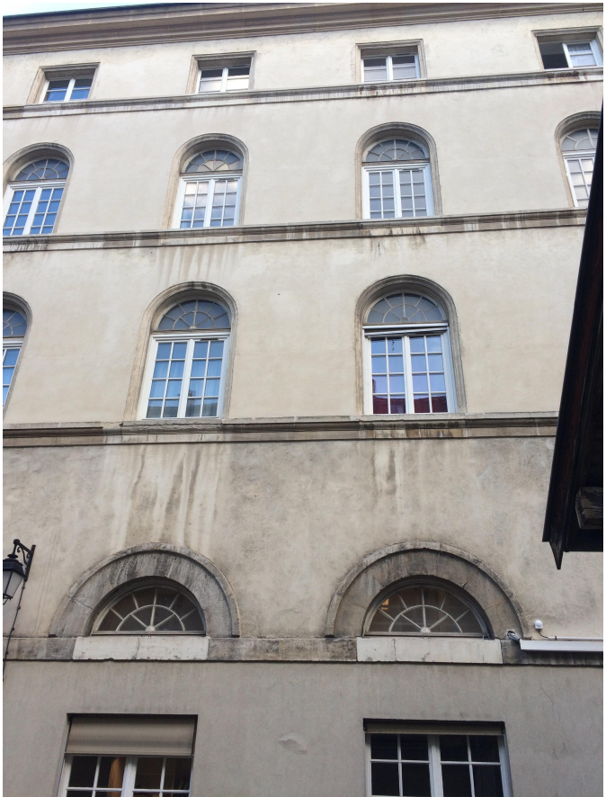
7. Vue rapprochée de la façade Ouest : dégradation des bandeaux
