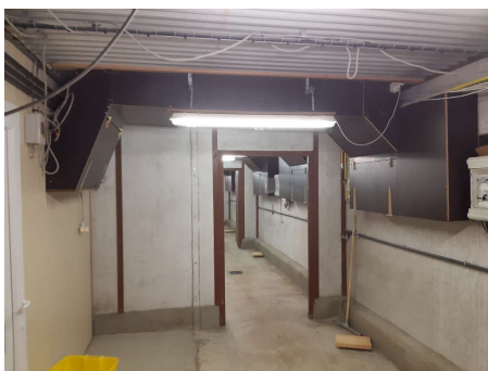
Prise d'air neuf traversant le couloir
