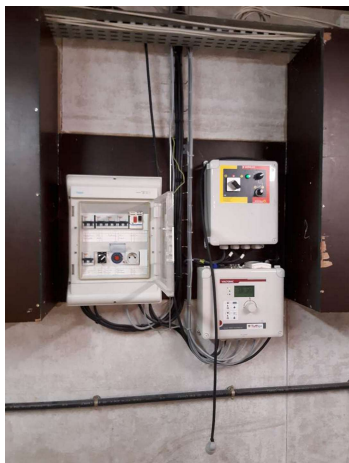
Boîtiers de régulation par cellule
