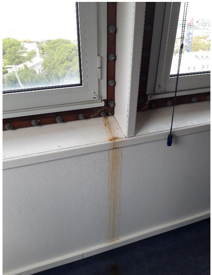
Défaut d'étanchéité de menuiserie
