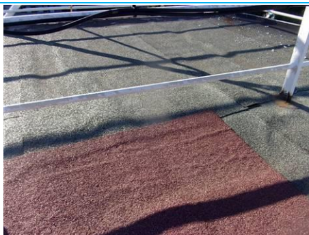
Matériaux : ZPSO-001 Prélèvement : P001 Description : revêtement bitumineux Localisation : Toiture passerelle Résultat : Absence d'amiante Quantité :
