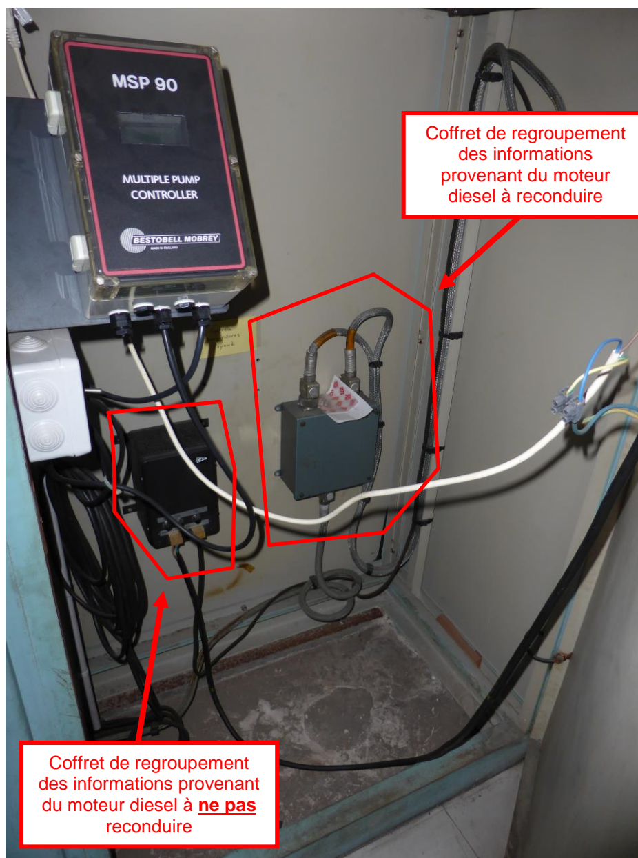
Coffret de regroupement et alimentation statique (vue interne Tableau Relais)
