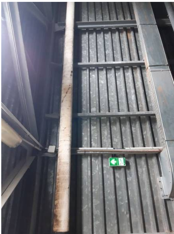
Calorifugeage présent dans la cage d'escalier ayant fait l'objet d'un prélèvement.
