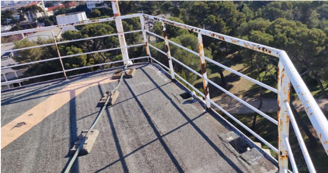
Figure 22 - Relevés d'étanchéité du toit de la passerelle.
