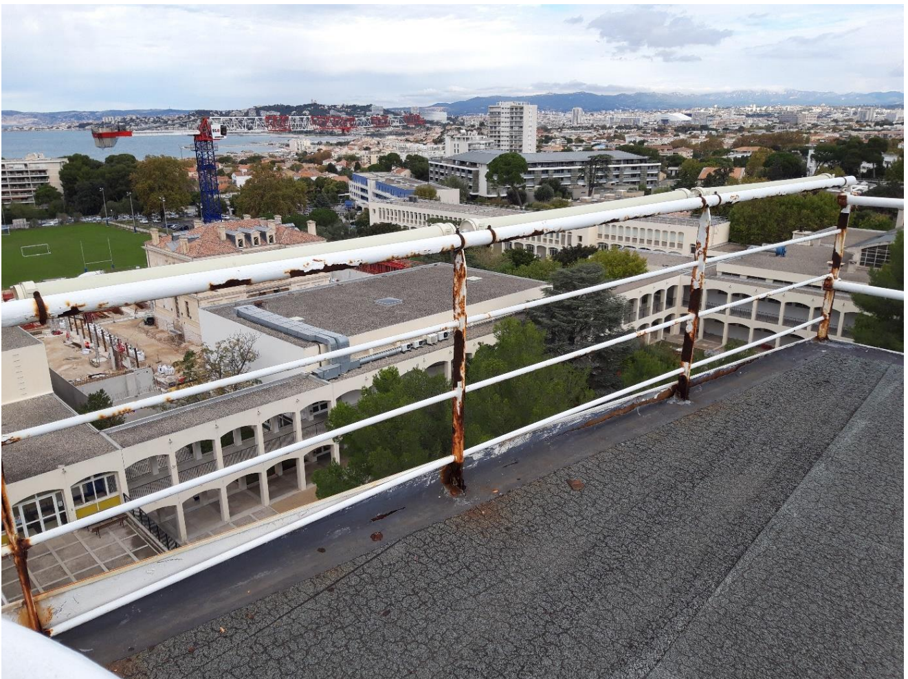
Etanchéité non traitée au droit des fixations du garde-corps
