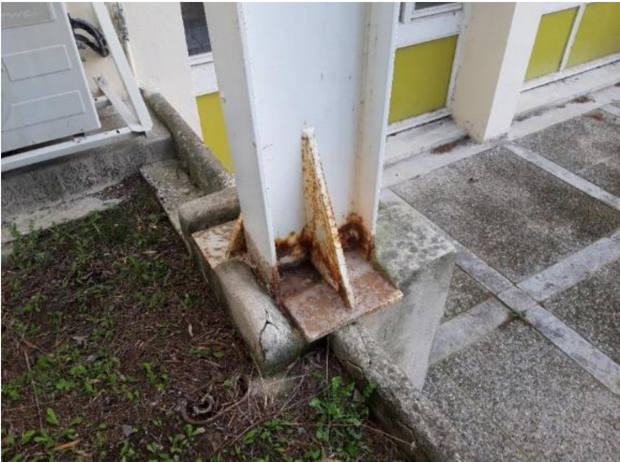
Corrosion avancée en pied de poteau
