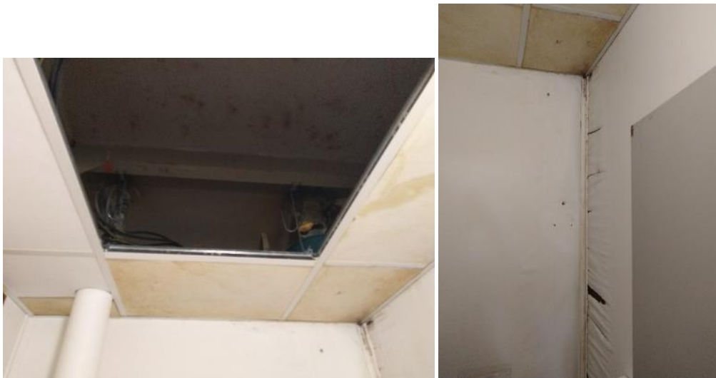
Figure 27- Défaut d'étanchéité dans le sanitaire (plafond et cloison dégradés)
