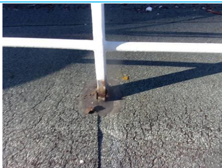
Matériaux : ZPSO-005 Prélèvement : P005 Description : Peintures Garde-corps Localisation : Toiture passerelle Résultat : Absence d'amiante Quantité :
