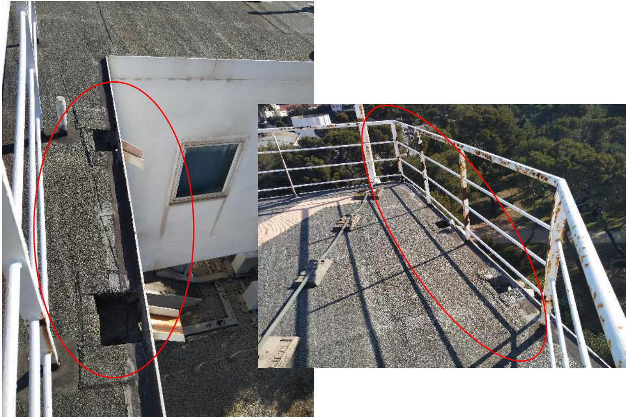
Figure 26- Dispositif d'évacuation des eaux pluviales
