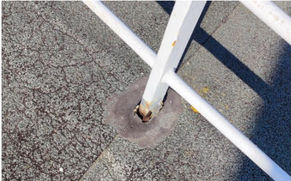
Figure 24 - Défaut de traitement des pénétrations
