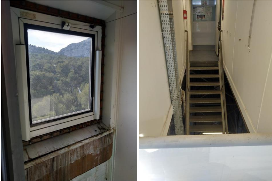
Figure 8 – Ouvrant de désenfumage en partie supérieur du volume de l'escalier d'accès
