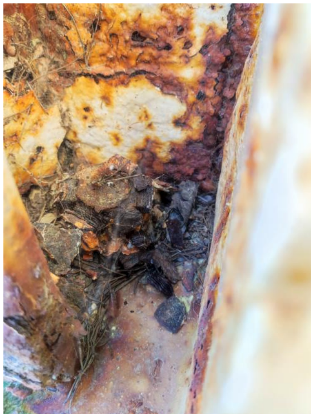
Figure 17 - Détail sur l'appui de poteau Nord-Est de la Passerelle
