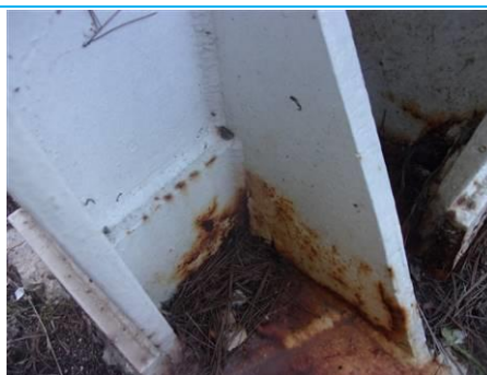
Matériaux : ZPSO-013 Prélèvement : P013 Description : Peintures encrages Localisation : Rez de jardin Résultat : Absence d'amiante Quantité :
