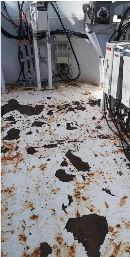
Dégradation de parties métalliques
