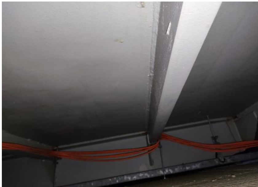
Figure 25- Toiture métallique étanchée et isolée de la Passerelle
