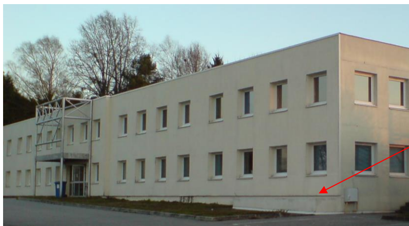
Pont thermique en pied de façade
