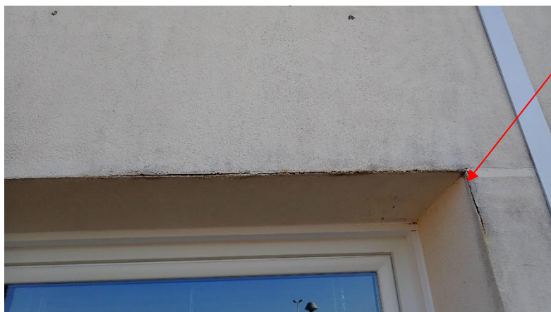
Dégradation du revêtement du complexe isolant au niveau des arrêtes.
