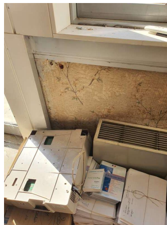
Déclaré - : DDFIP MARMANDE / RDC / Pièce 2 - Revêtement dur - EP- (Présence d'amiante)
