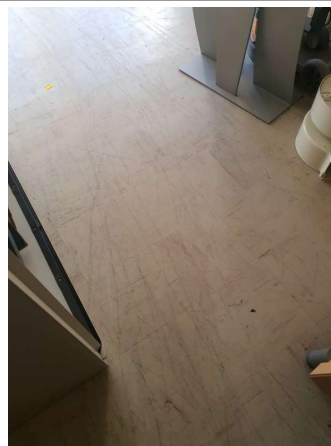
Déclaré - : DDFIP MARMANDE / RDC / Pièce 4 - Dalle de sol - AC1- (Présence d'amiante)
