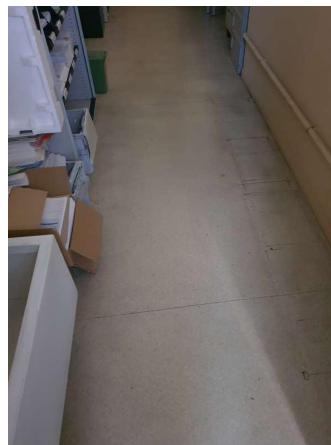
Déclaré - : DDFIP MARMANDE / RDC / Courrier - Dalle de sol - EP- (Présence d'amiante)
