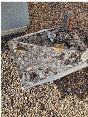
Déclaré - : DDFIP MARMANDE / Toiture Chaufferie - Plaque - EP- (Présence d'amiante)
