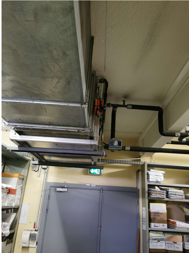
Exemple reprise réseau alimentation Eau chaude du caisson de soufflage.
