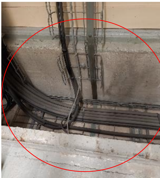
Caniveau au niveau de l'implantation TGBT EDF
