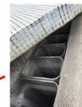
conduit de ventilation fibro ciment
