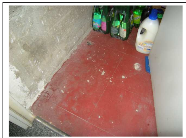
Présence d'amiante reconnue après analyse pour les dalles de sol + colle situées dans le placard au 4 ème étage
