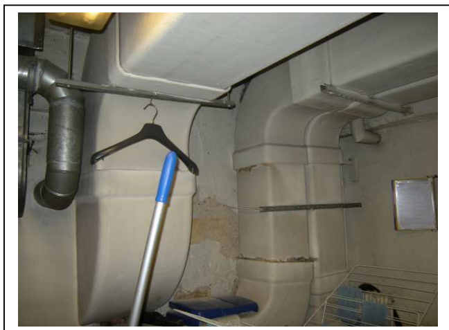
Présence d'amiante reconnue sur décision de l'opérateur de repérage pour les conduits fibrociment situés dans le local ménage
