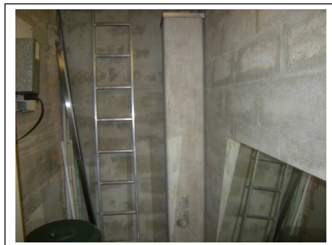
Présence d'amiante reconnue sur décision de l'opérateur de repérage pour le conduit fibrociment situé dans la machinerie ascenseur
