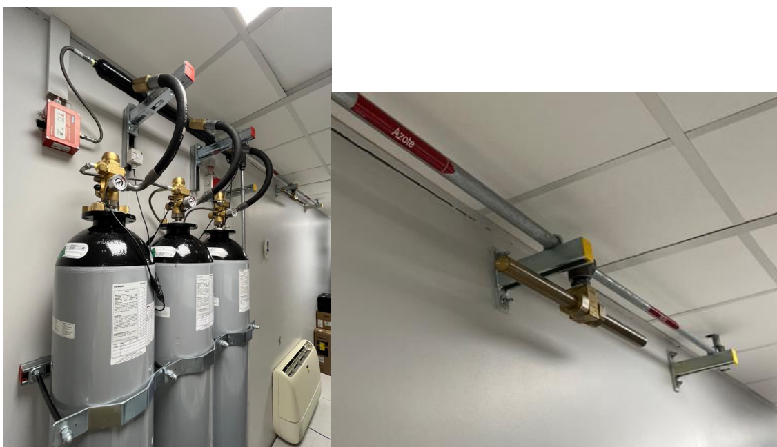
DAC de pilotage, réseau d'extinction et bouteilles
