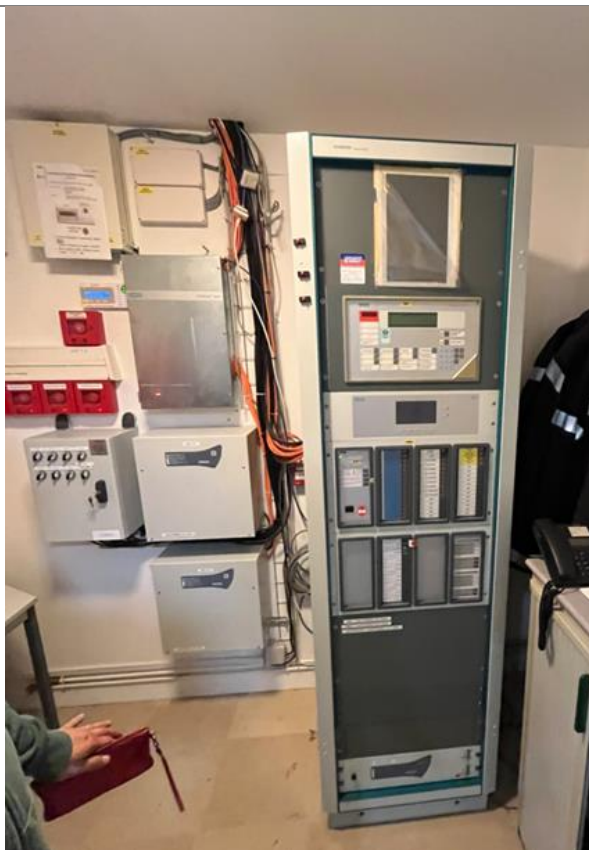
Centrale incendie présentée en baie avec en partie haute l'ECS à migrer et en dessous le CMSI (existant conservé), ensemble est de marque SIEMENS
