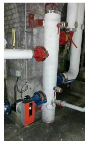
Echnageur primaire et bouteille de mélange
