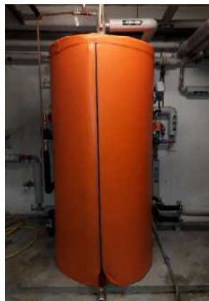
Ballon ECS et pompe bouclage
