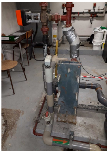
Echangeur en service (sous dimensionné)
