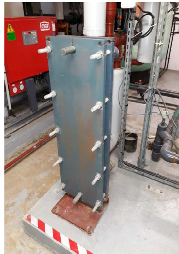
Echangeur isolé du circuit
