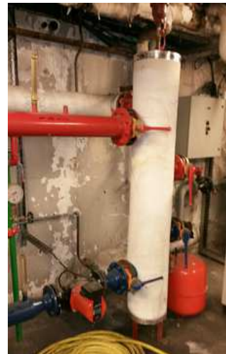
Echangeur primaire et bouteille de mélange
