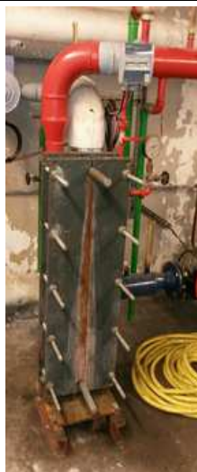
Echangeur primaire et bouteille de mélange
