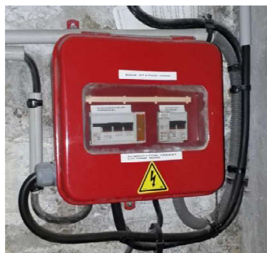
Coupure électrique (située dans la SST)
