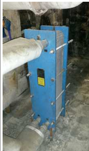
Echangeur primaire et bouteille de mélange
