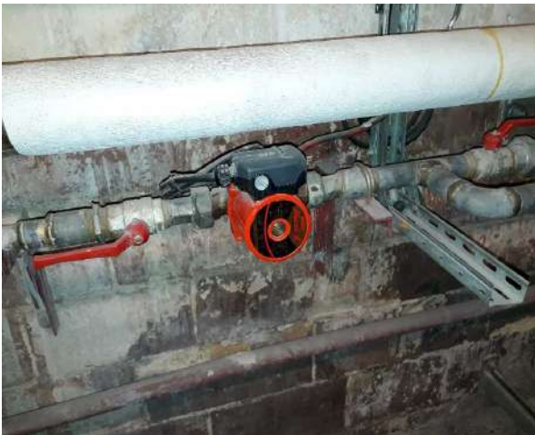
Bouclage ECS (non calorifugé)
