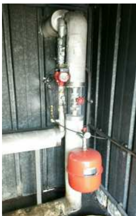
Panoplie hydraulique et vase expansion
