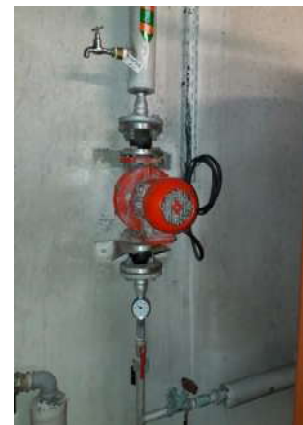
Ballon ECS et pompe bouclage
