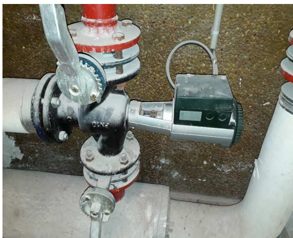
Vanne trois voies chauffage
