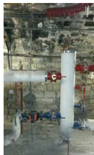
Echangeur primaire et bouteille de mélange
