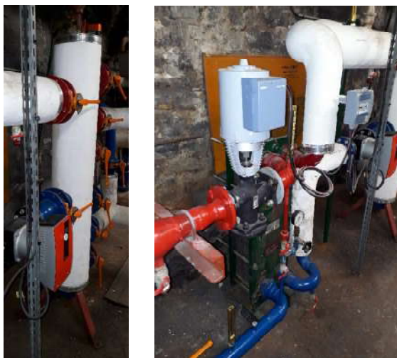
Echangeur primaire et bouteille de mélange
