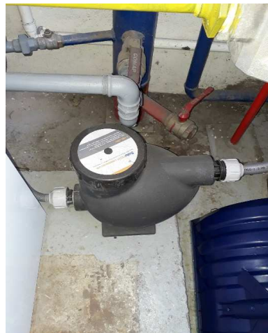
Bac de neutralisation des condensats
