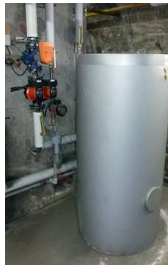
Production ECS et bouclage ECS
