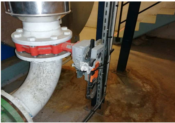
Vanne deux voies à réparer
