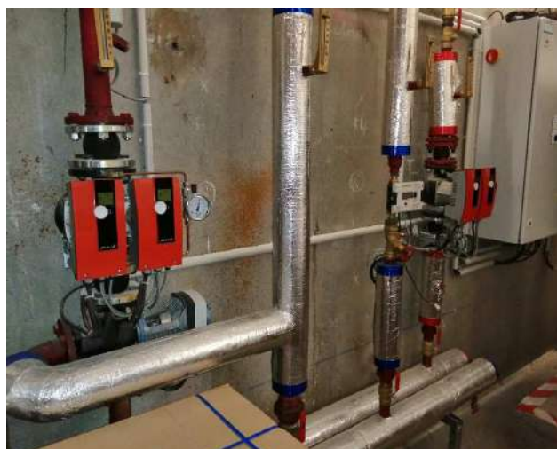
Panoplie chauffage sous-station nouvelle école de kiné
