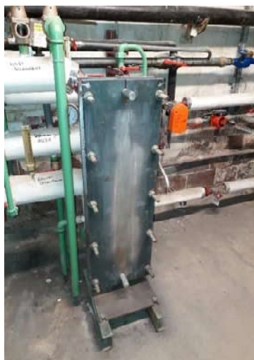
Echangeur primaire (évacuation de soupape manquante)
