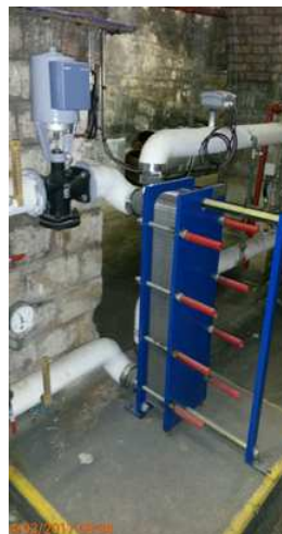
Echnageur primaire et bouteille de mélange
