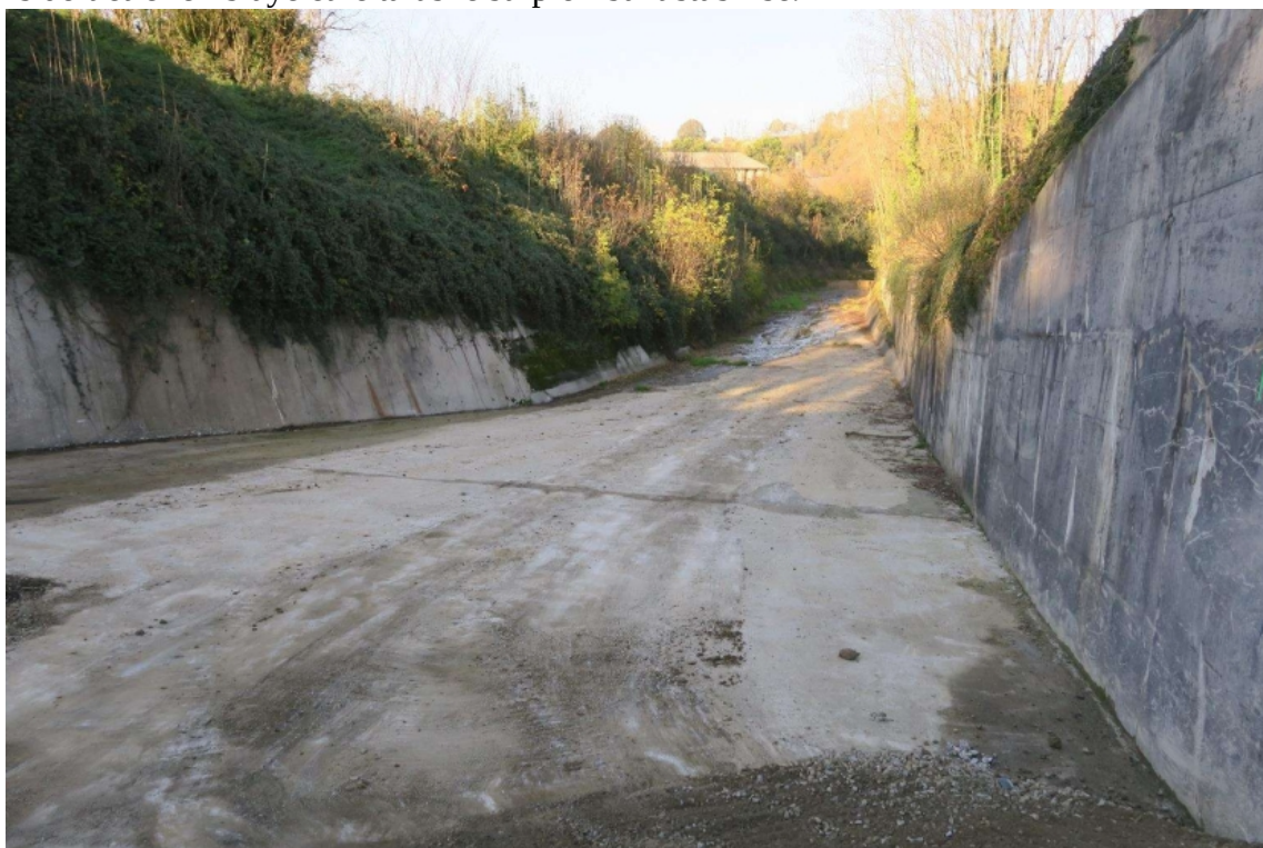
Figure 3 : Canal évacuateur de crues.
