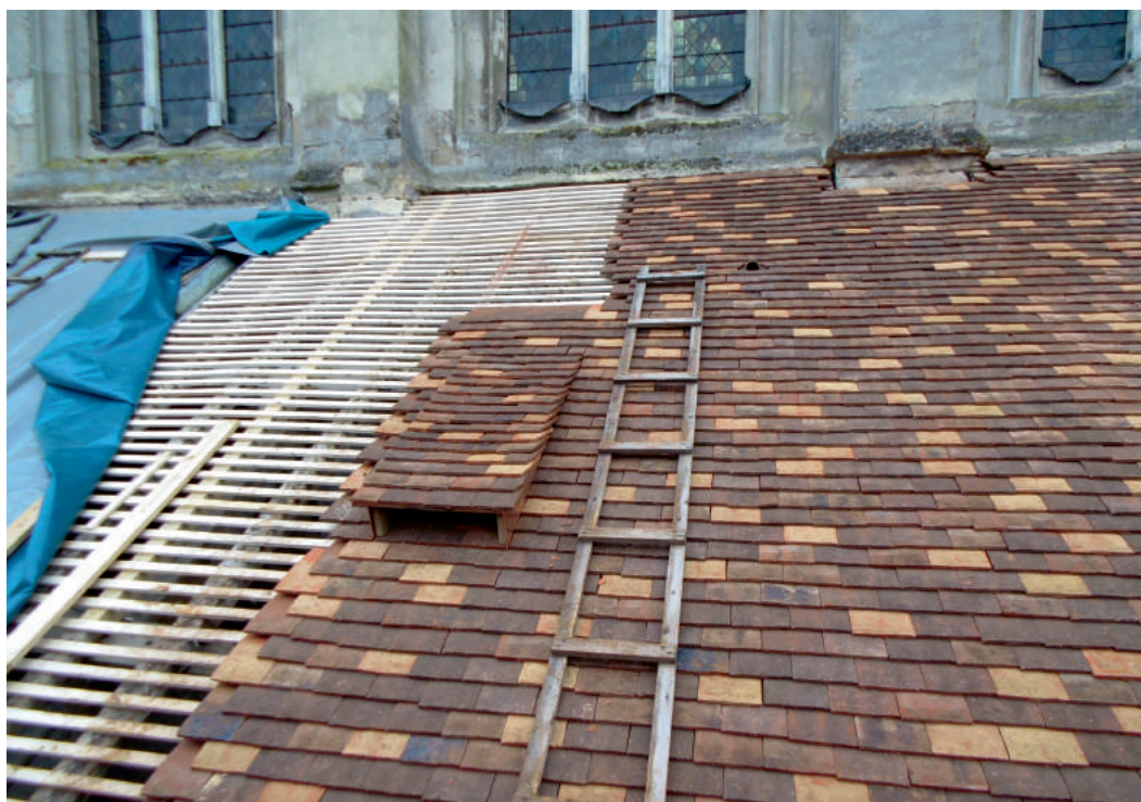
Aménagement d'une chiropièrre au niveau de la toiture de l'église de Montfort-l'Amaury (Arnaud Bak, PNR de la Haute Vallée de Chevreuse)
