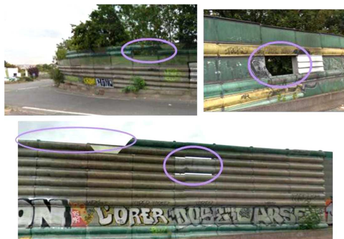
Dégradations des écrans existants
