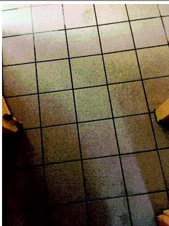
Prélèvement - P23 : REZ DE CHAUSSEE / DGT 010 - Colle de carrelage- (Absence d'amiante)
