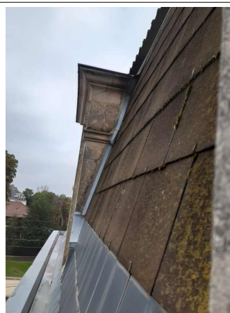
Prélèvement - P10 : Toiture / Couverture - Ardoise- (Présence d'amiante)
