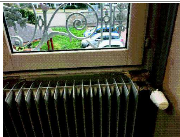
Prélèvement - P16 : ETAGE 1 / SALLE DE REUNION - Joint d'étanchéité entre menuiserie et structure- (Absence d'amiante)
