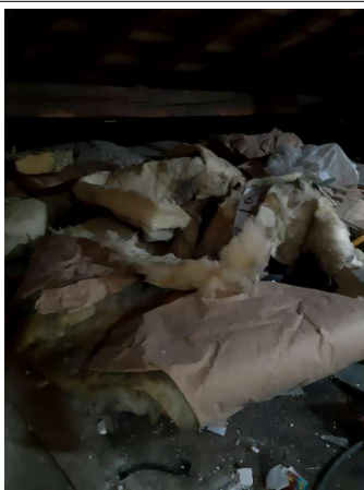
Prélèvement - P7 : Toiture / Combles - Pare-vapeur- (Absence d'amiante)
