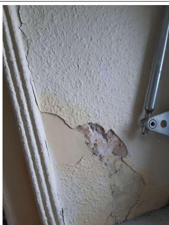
Prélèvement - P3 : R+2 / Palier 4 - Enduit- (Présence d'amiante)
