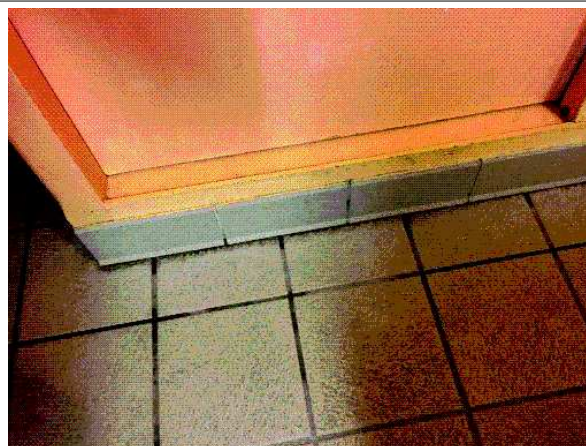
Prélèvement - P24 : REZ DE CHAUSSEE / DGT 010 - Colle de plinthe- (Absence d'amiante)
