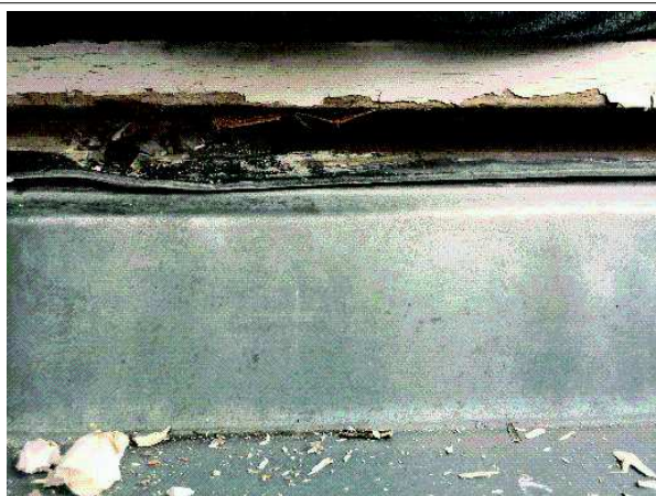
Prélèvement - P7 : COMBLES / BUREAU 13 - Joint d'étanchéité entre menuiserie et structure- (Absence d'amiante)
