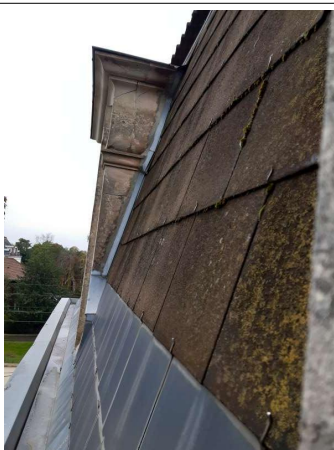
Prélèvement - P9 : Toiture / Couverture - Ardoise- (Présence d'amiante)
