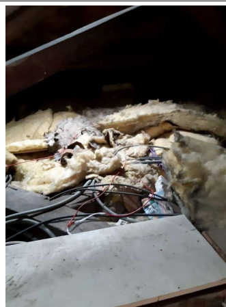
Prélèvement - P8 : Toiture / Combles - Pare-vapeur- (Absence d'amiante)
