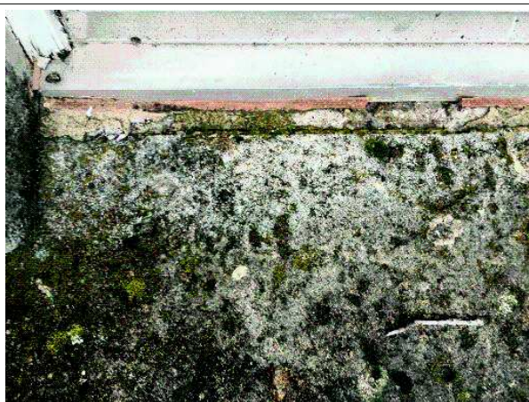
Prélèvement - P9 : ETAGE 1 / BUREAU 6 - Joint d'étanchéité entre menuiserie et structure- (Absence d'amiante)
