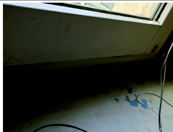
Prélèvement - P6 : COMBLES / BUREAU 13 - Joint d'étanchéité entre menuiserie et structure- (Absence d'amiante)
