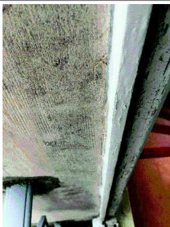
Prélèvement - P11 : ETAGE 1 / ESCALIER - Joint d'étanchéité entre menuiserie et structure- (Absence d'amiante)
