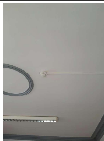
Prélèvement - P14 : RDC / Salle d'activités - Enduit- (Absence d'amiante)
