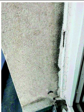
Prélèvement - P5 : COMBLES / BUREAU 13 - Joint d'étanchéité entre menuiserie et structure- (Absence d'amiante)
