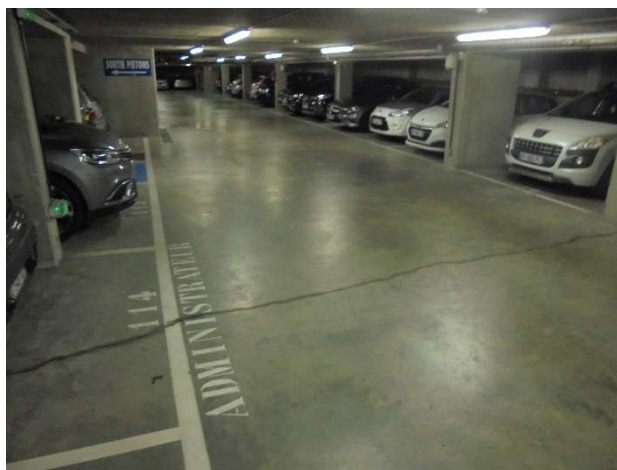
Fissure vue depuis l'extrados de la dalle
