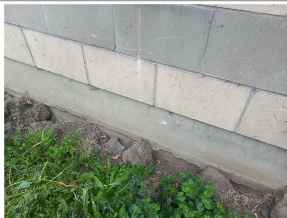
Prélèvement - P002 : MAISON D'ARRET / EXTERIEUR / SALLE D'ATTENTE FAMILLE - Enduit- (Absence d'amiante)
