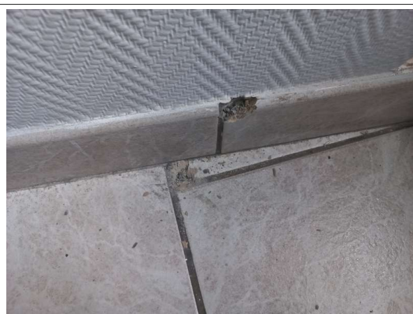
Prélèvement - P030 : MAISON D'ARRET / R+1 / LOCAL R.L.E - Colle de carrelage- (Absence d'amiante)
