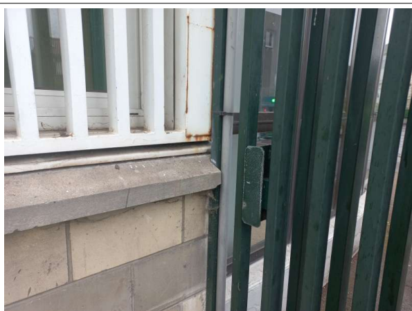
Prélèvement - P003 : MAISON D'ARRET / EXTERIEUR / SALLE D'ATTENTE FAMILLE - Appui de fenêtre en fibres- ciment- (Absence d'amiante)
