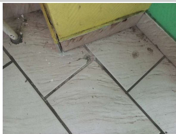
Prélèvement - P008 : MAISON D'ARRET / RDC / LOCAL ATTENTE FAMILLE - Colle de carrelage- (Absence d'amiante)
