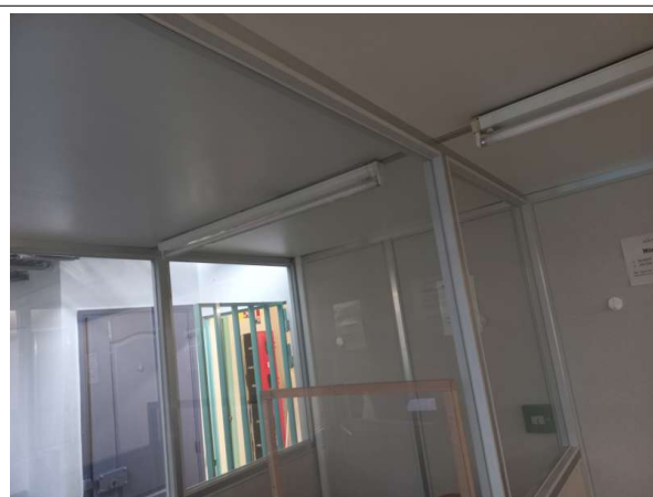
Déclaré - : MAISON D'ARRET / R+1 / CABINE AVOCATS - Panneau- (Absence d'amiante)
