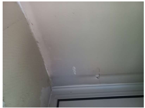
Prélèvement - P014 : MAISON D'ARRET / RDC / LOCAL ATTENTE FAMILLE - Enduit- (Absence d'amiante)
