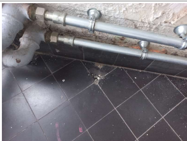
Prélèvement - P015 : MAISON D'ARRET / R+1 / ATTENTE PARLOIRS FAMILLE - Colle de carrelage- (Absence d'amiante)
