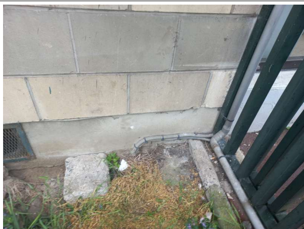
Prélèvement - P001 : MAISON D'ARRET / EXTERIEUR / SALLE D'ATTENTE FAMILLE - Enduit- (Absence d'amiante)
