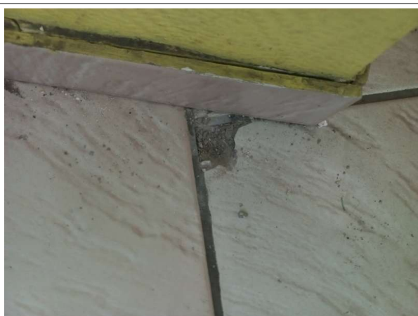
Prélèvement - P009 : MAISON D'ARRET / RDC / LOCAL ATTENTE FAMILLE - Colle de carrelage- (Absence d'amiante)
