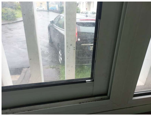
Prélèvement - P013 : MAISON D'ARRET / RDC / LOCAL ATTENTE FAMILLE - Joint de vitrage- (Absence d'amiante)
