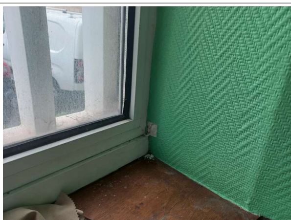
Prélèvement - P011 : MAISON D'ARRET / RDC / LOCAL ATTENTE FAMILLE - Enduit- (Absence d'amiante)
