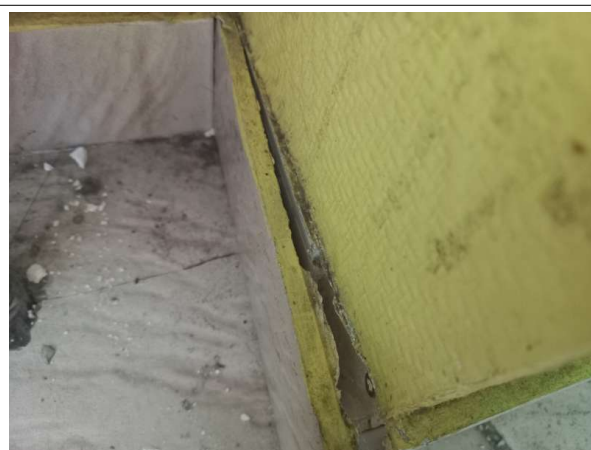
Prélèvement - P010 : MAISON D'ARRET / RDC / LOCAL ATTENTE FAMILLE - Colle de plinthe- (Absence d'amiante)
