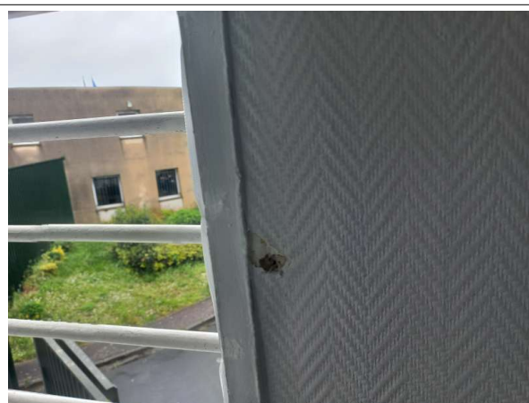
Prélèvement - P028 : MAISON D'ARRET / R+1 / LOCAL R.L.E - Enduit- (Absence d'amiante)
