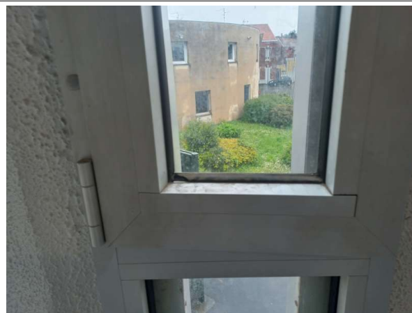
Prélèvement - P020 : MAISON D'ARRET / R+1 / ATTENTE PARLOIRS FAMILLE - Joint- (Absence d'amiante)
