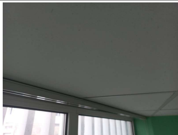
Déclaré - : MAISON D'ARRET / RDC / LOCAL ATTENTE FAMILLE - Faux plafond- (Absence d'amiante)
