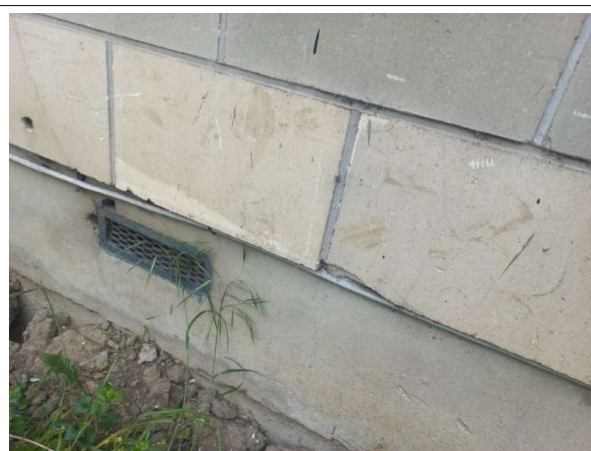
Prélèvement - P006 : MAISON D'ARRET / EXTERIEUR / SALLE D'ATTENTE FAMILLE - Colle- (Absence d'amiante)
