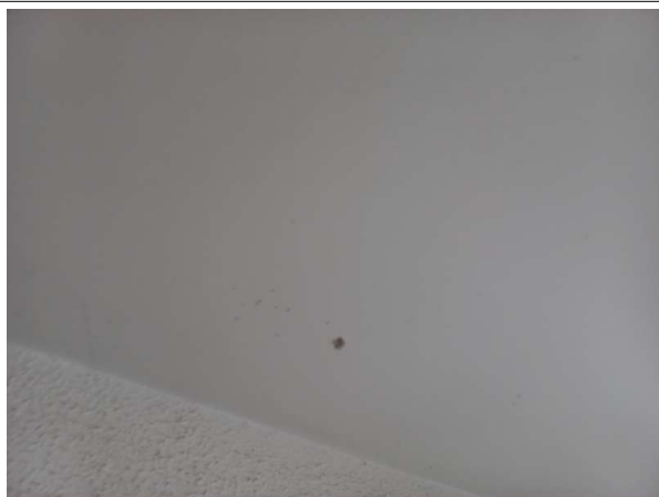
Prélèvement - P019 : MAISON D'ARRET / R+1 / ATTENTE PARLOIRS FAMILLE - Enduit- (Absence d'amiante)
