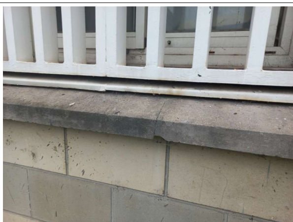
Prélèvement - P005 : MAISON D'ARRET / EXTERIEUR / SALLE D'ATTENTE FAMILLE - Appui de fenêtre en fibres- ciment- (Absence d'amiante)
