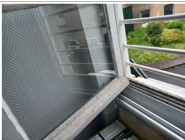
Prélèvement - P027 : MAISON D'ARRET / R+1 / LOCAL R.L.E - Mastic- (Absence d'amiante)
