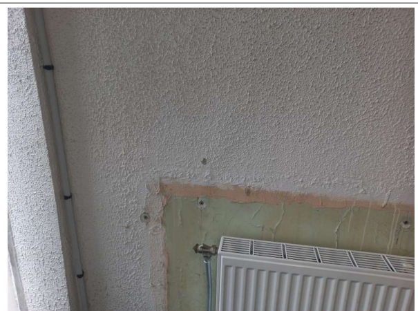
Prélèvement - P018 : MAISON D'ARRET / R+1 / ATTENTE PARLOIRS FAMILLE - Enduit- (Absence d'amiante)
