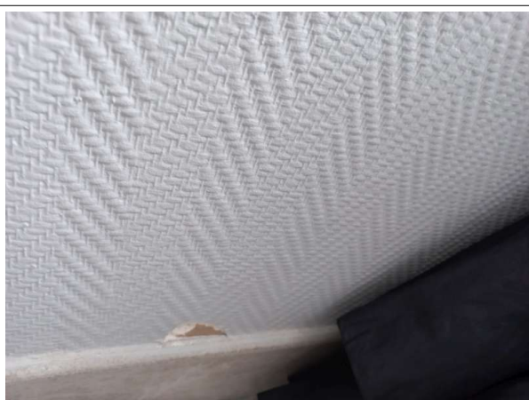
Prélèvement - P029 : MAISON D'ARRET / R+1 / LOCAL R.L.E - Enduit- (Absence d'amiante)
