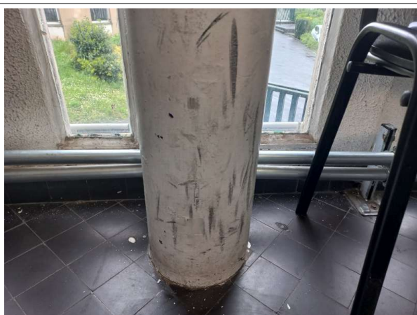
Prélèvement - P021 : MAISON D'ARRET / R+1 / ATTENTE PARLOIRS FAMILLE - Enduit- (Présence d'amiante)
