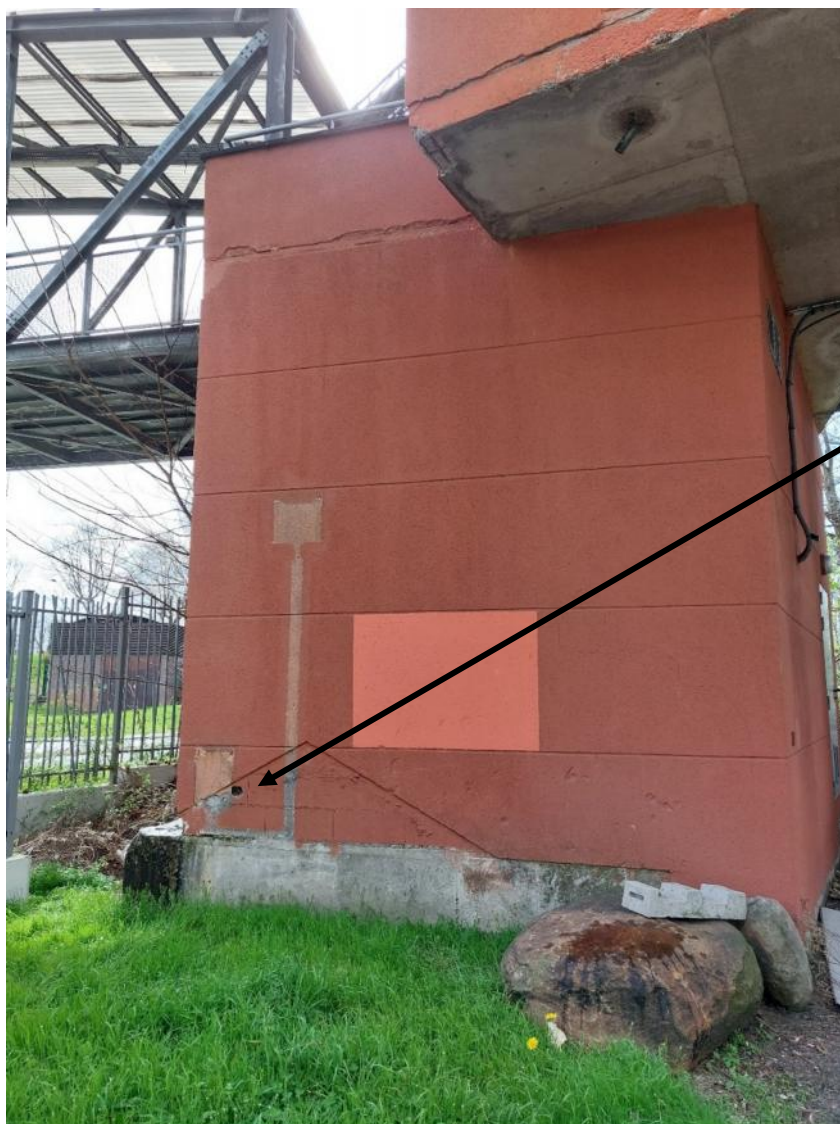
Mur en parpaing creux épaisseur 20 cm
