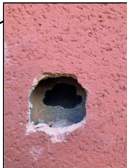
Mur en parpaing creux épaisseur 20 cm
