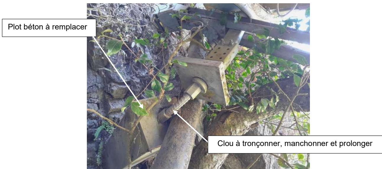
Figure 10 : Ancrage n° 6 à remplacer / réparer
