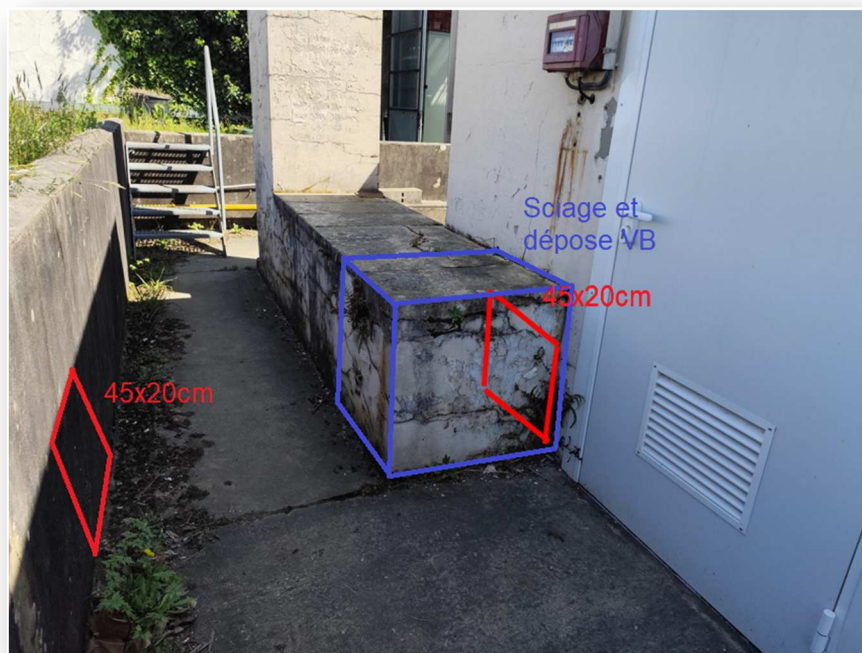
Sciage et dépose de la VB et réservation 45x20cm du bâtiment 15
