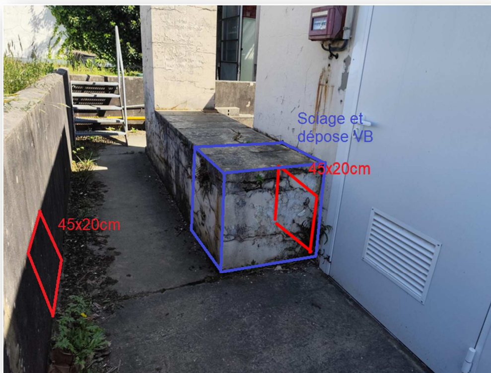
Sciage et dépose de la VB et réservations 45x20cm du bâtiment 15
