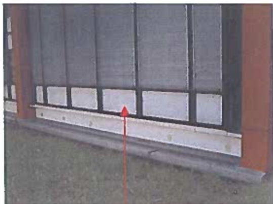
Allèges de fenêtres en amiante ciment
