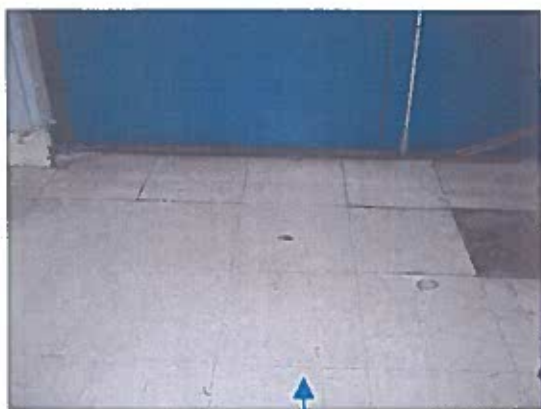
Prélèvement P1 : Dalles de sol blanches 26,5x26,5 ne contenant pas de fibres d'amiante
