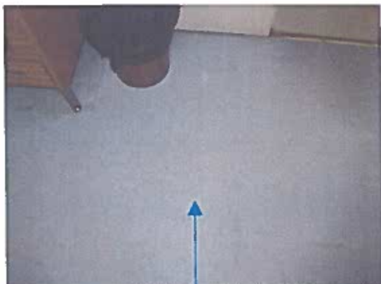
Prélèvement P9 : Dalles de sol bleu clair ne contenant pas de fibres d'amiante
