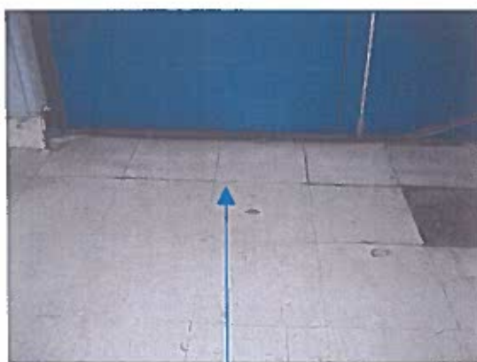
Prélèvement P2 : Dalles de sol blanches 30x30 ne contenant pas de fibres d'amiante
