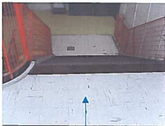
Prélèvement P15 : Dalles de sol blanches rayées noir ne contenant pas de fibres d'amiante
