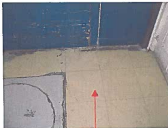
Prélèvement P12 : Dalles de sol crème et colle noire contenant des fibres d'amiante
