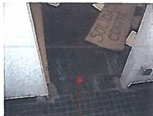
Prélèvement P6 : Dalles de sol noires et colle noire contenant des fibres d'amiante
