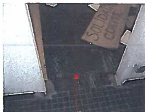
Prélèvement P6 : Dalles de sol noires et colle noire contenant des fibres d'amiante
