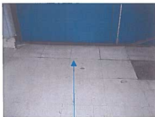
Prélèvement P2 : Dalles de sol blanches 30x30 ne contenant pas de fibres d'amiante
