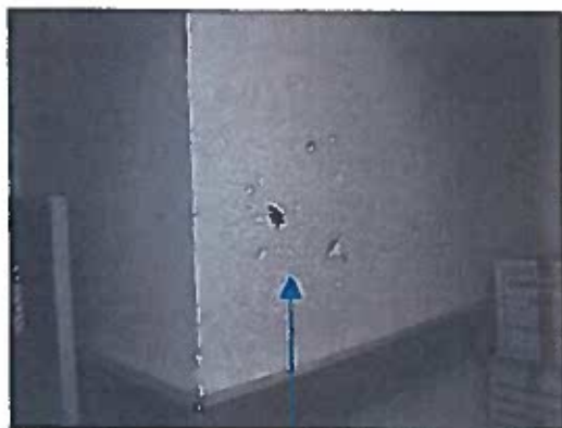
Prélèvement P3 : Revêtement mural acoustique
