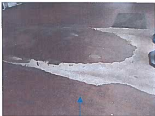
Prélèvement P13 : Revêtement de sol rouge ne contenant pas de fibres d'amiante
