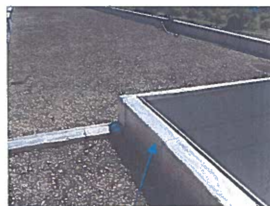
Prélèvement P4 : Relevé d'étanchéité en acrotère ne contenant pas de fibres d'amiante
