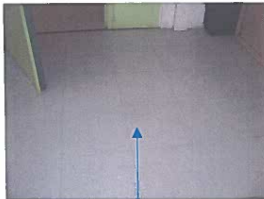
Prélèvement P8 : Dalles de sol blanches rayées noir ne contenant pas de fibres d'amiante
