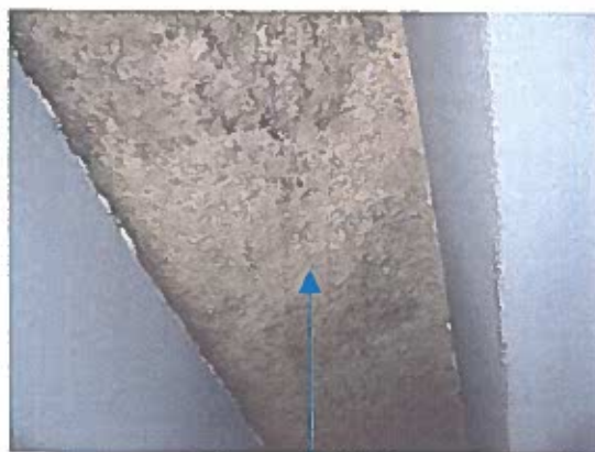
Prélèvement P17 : Flocage ne contenant pas de fibres d'amiante
