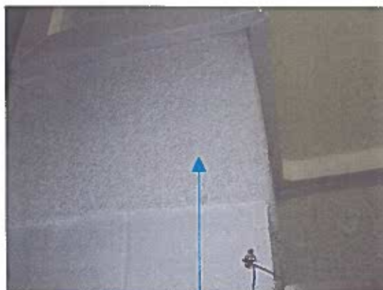
Prélèvement P18 : Flocage (Billes de polystyrène et liant projetés) ne contenant pas de fibres d'amiante
