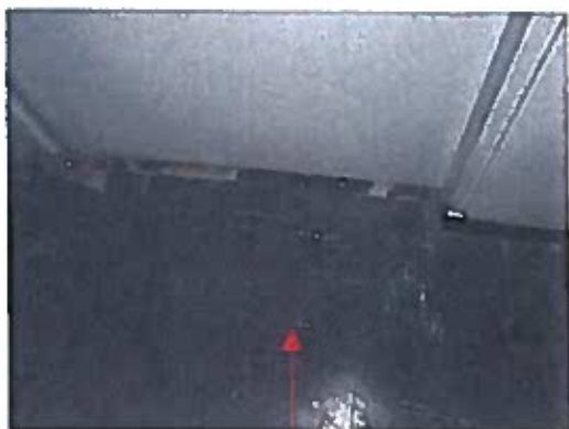
Prélèvement P1 : Dalles de sol noires et colle noire contenant des fibres d'amiante
