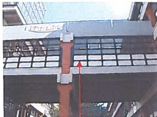
Allèges de fenêtres en amiante ciment
