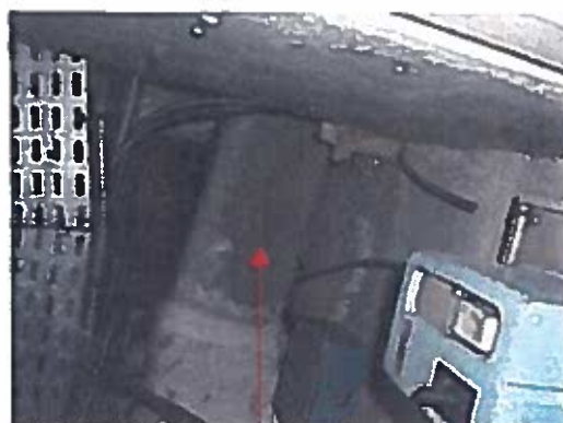
Conduit de ventilation en amiante ciment (Rez-de-chaussée - Hall LT)
