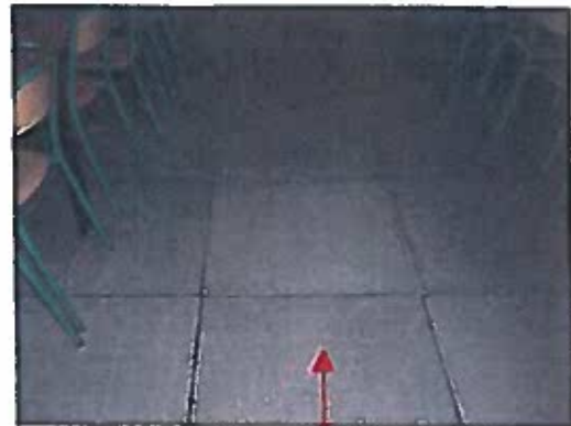
Prélèvement P2 : Dalles de sol grises sur faux plancher technique contenant des fibres d'amiante
