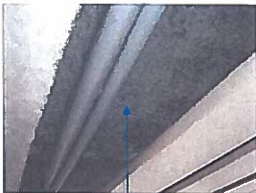
Prélèvement P7 : Flocage
