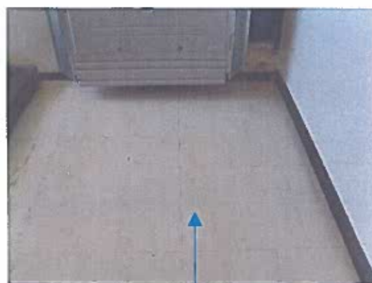
Prélèvement P3 : Dalles de sol crème rayées marron ne contenant pas de fibres d'amiante
