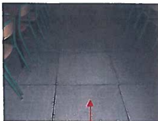
Prélèvement P2 : Dalles de sol grises sur faux plancher technique contenant des fibres d'amiante
