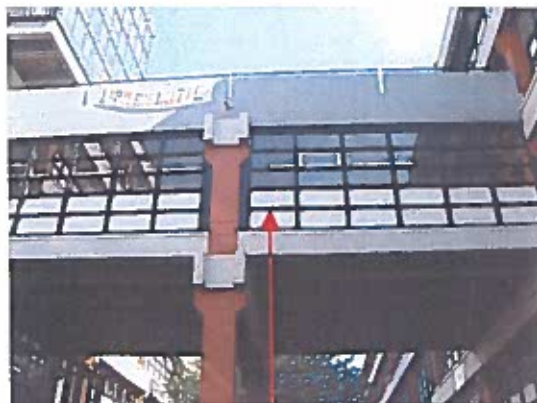
Allèges de fenêtres en amiante ciment
