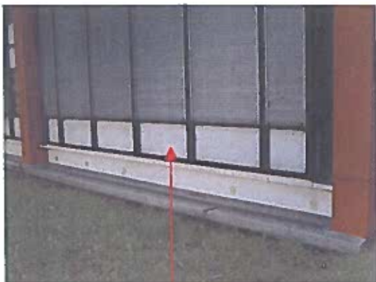
Allèges de fenêtres en amiante ciment
