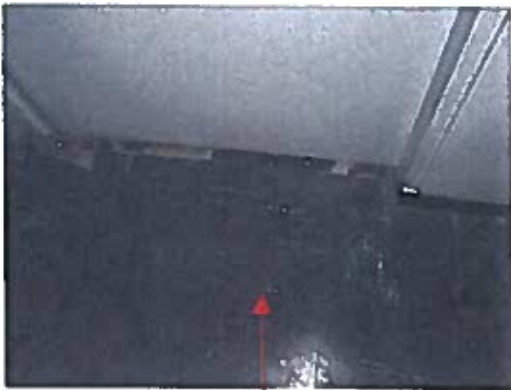
Prélèvement P1 : Dalles de sol noires et colle noire contenant des fibres d'amiante
